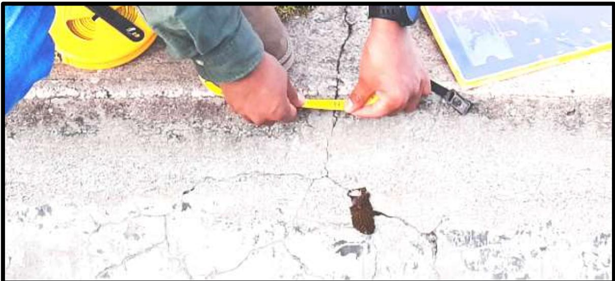
Fotografía N° 09. Fisuras y grietas del reservorio.
