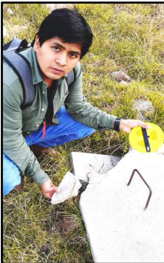
Fotografía N° 07. Tapa de la cámara romper presión quebrado.
