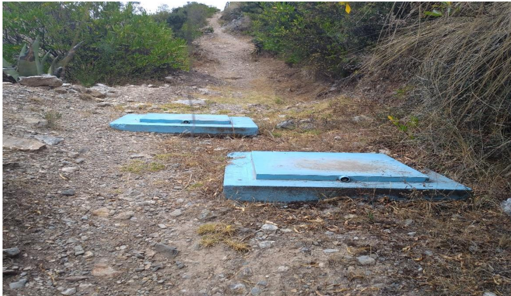
Fotografía N° 02 Línea de conducción
