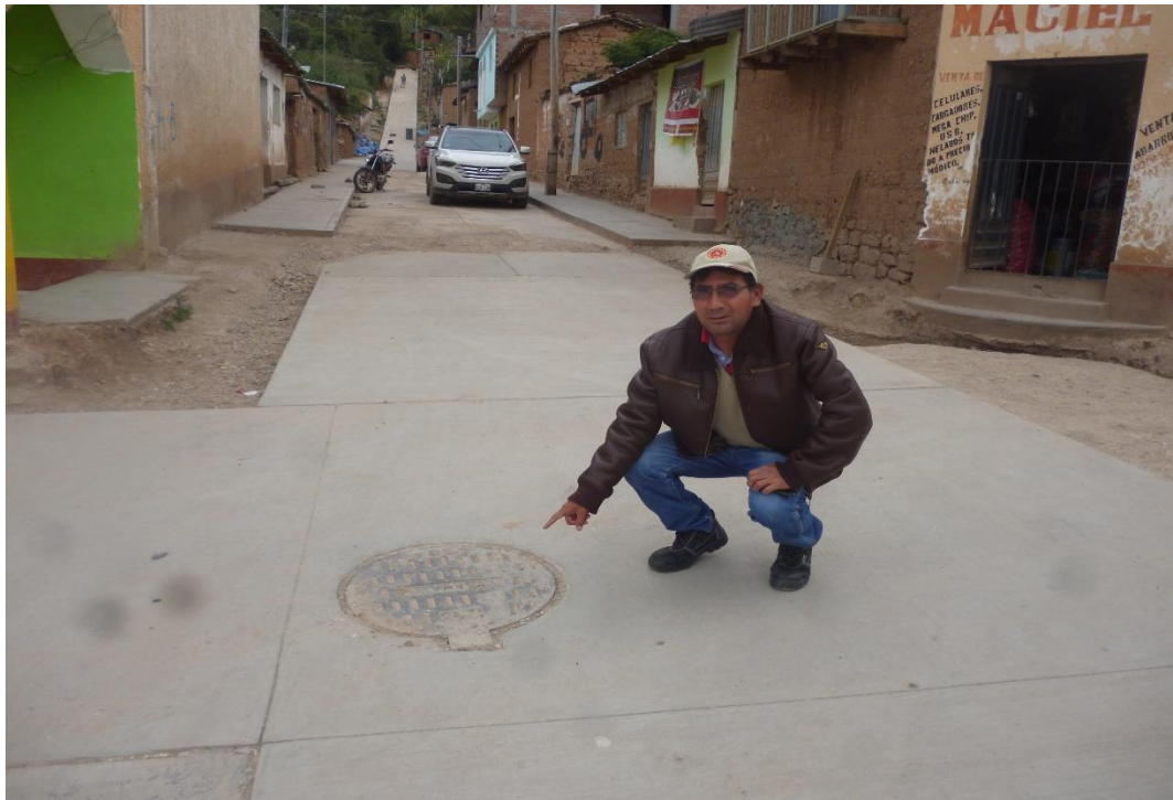
Fotografía N° 08 Red de aducción y distribución
