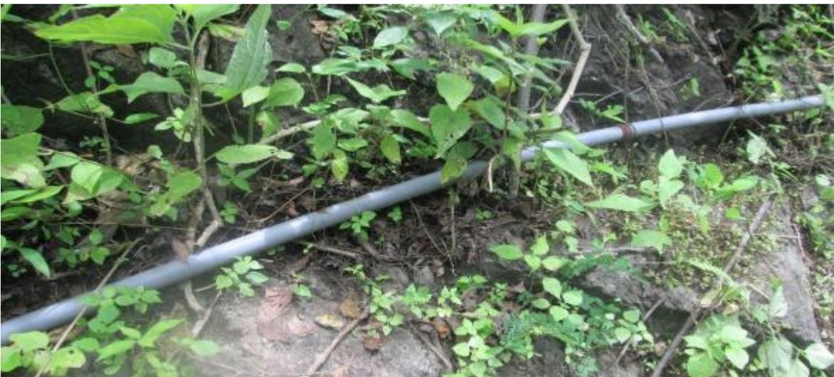
*Fotografía 5 tubería Expuesta y diámetro inadecuado*
