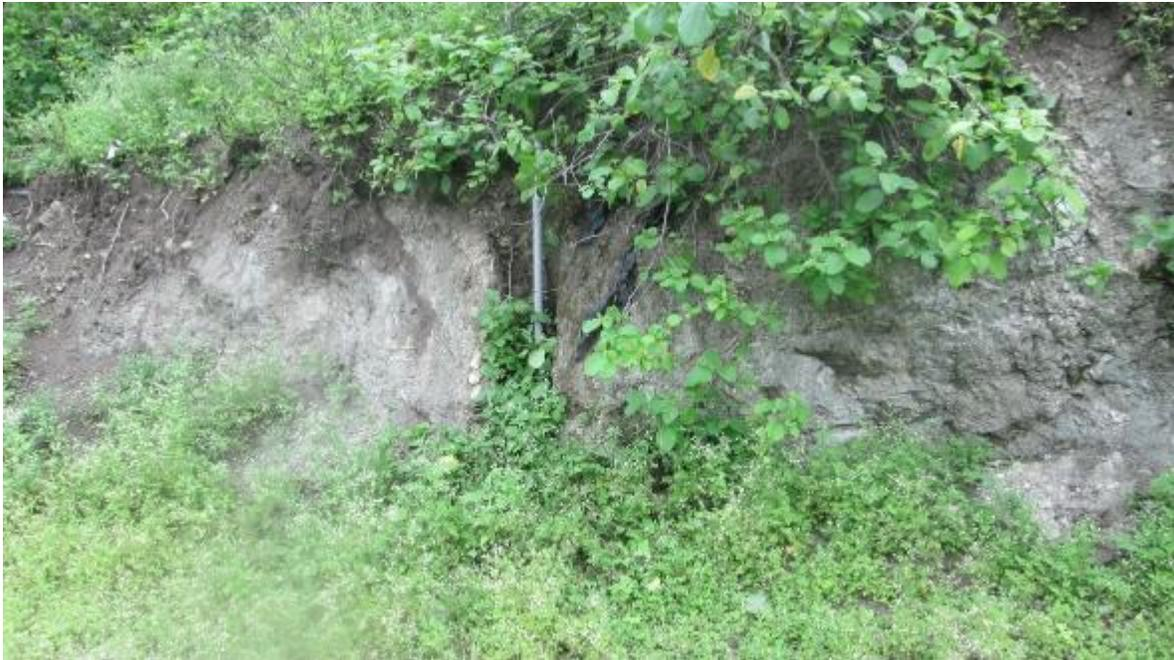
**Fotografía 19 Tubería expuesta en mal estado Sector La Florida**
