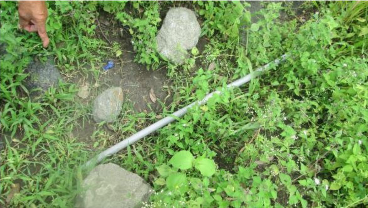
***Fotografía 7 Tubería Expuesta y diámetro inadecuado***
