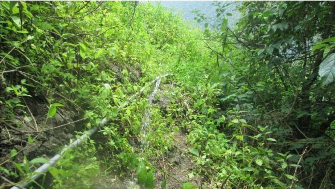
*Fotografía 6 Tubería Expuesta y diámetro inadecuado*
