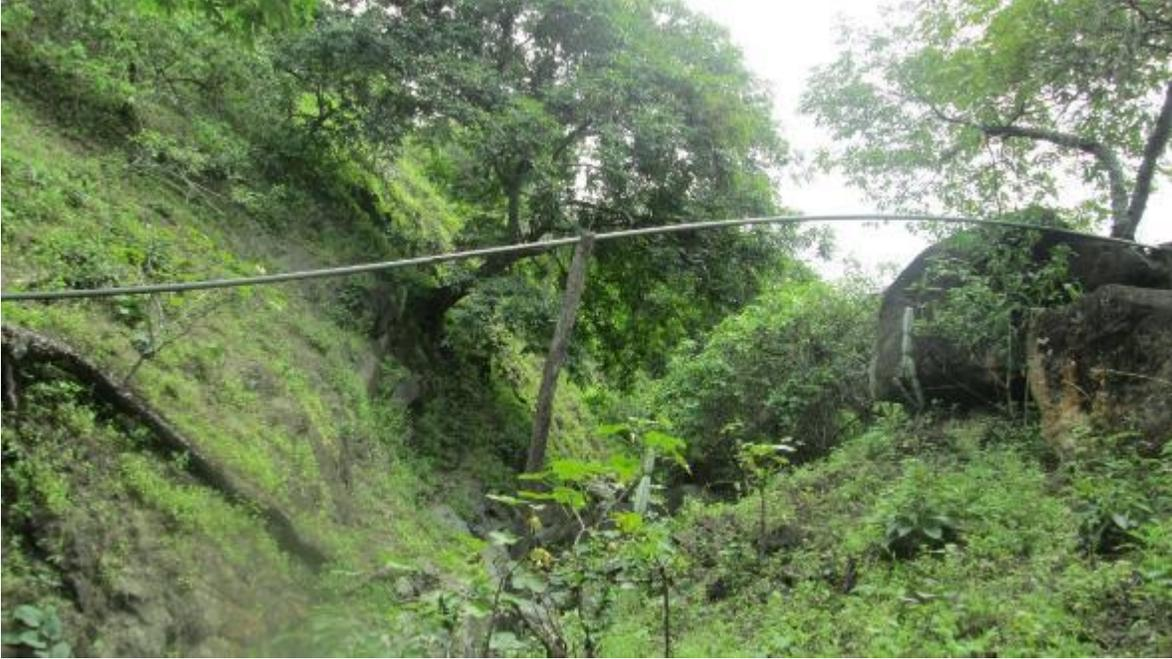
*Fotografía 8 Pase aéreo Con Tubería PVC en mal estado*
