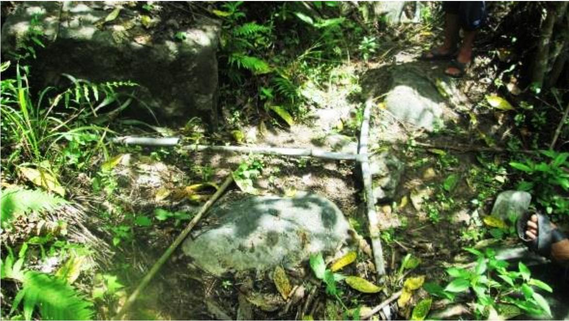
*Fotografía 4 Tubería Expuesta y diámetro inadecuado*
