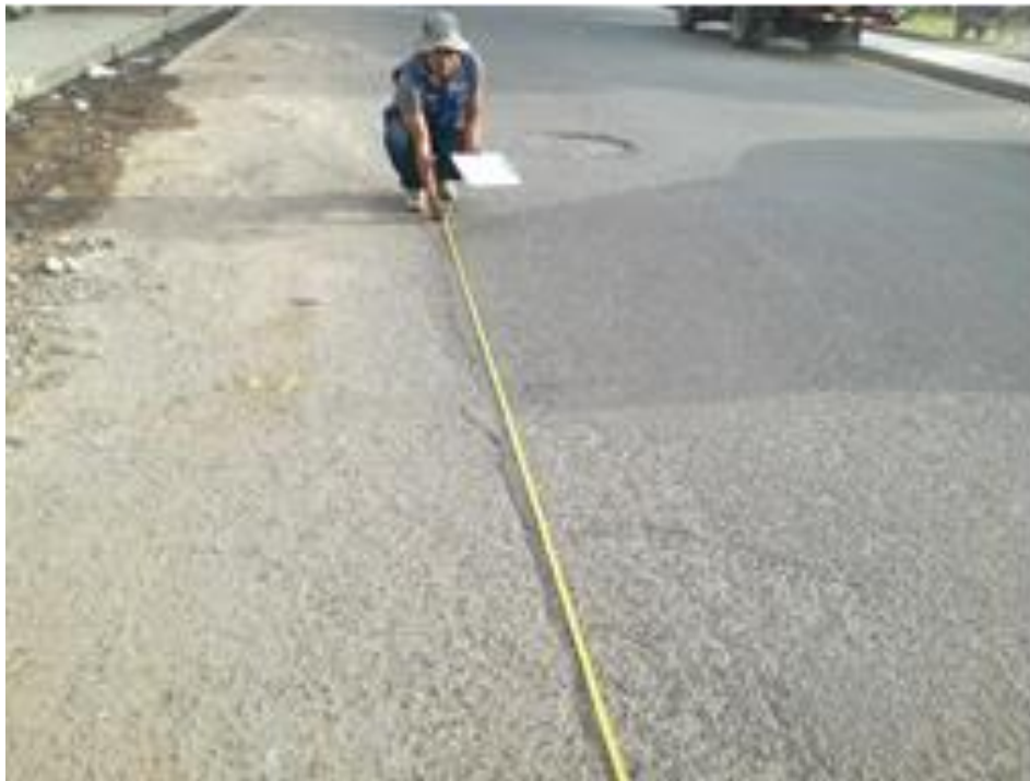
Figura 1: Pavimento flexible de la Av. Nicaragua (Fuente propia)
