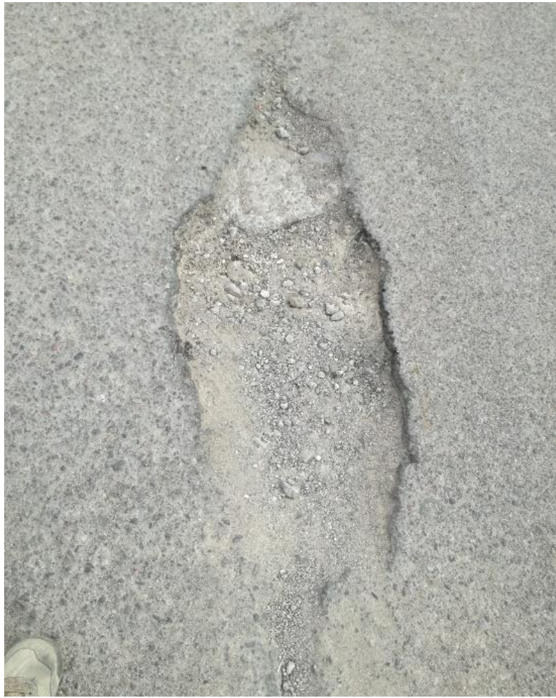
Foto 5: Huevo en la progresiva 0+240 (Fuente propia)
