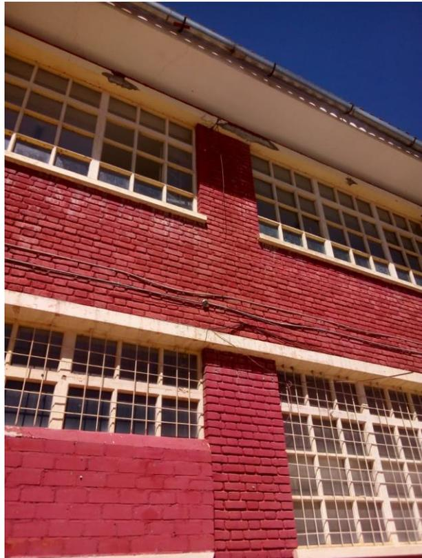
**Imagen N° 29.** Columnas de ladrillos sosteniendo la estructura del pabellón “C”
