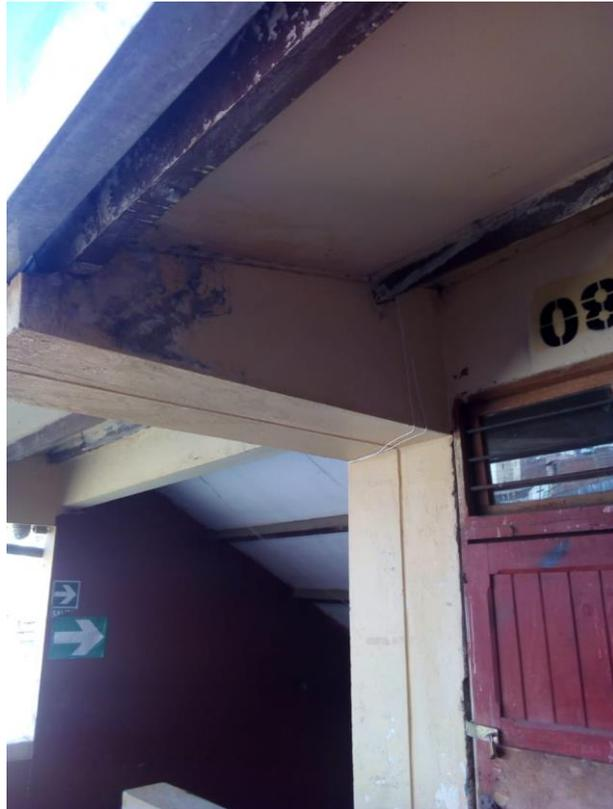
**Imagen N° 21.** Presencia de moho en bóveda del 2° piso del pabellón “D”
