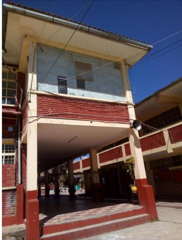
**Imagen N° 25.** Vista lateral izquierda del pabellón “C” donde se observa humedad y moho en su bóveda
