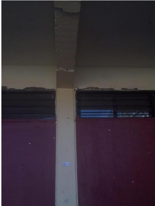
**Imagen N° 11.** Grietas y fisuras en columnas y desprendimiento de viga, pabellón "B"
