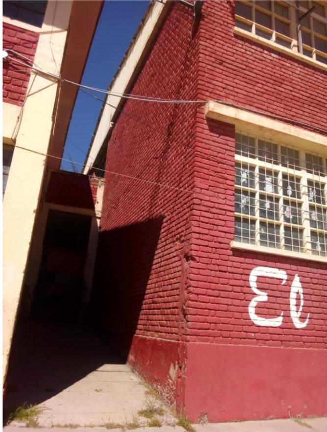
**Imagen N° 31.** Desintegración de sobrecimiento y muro de albañilería del pabellón
