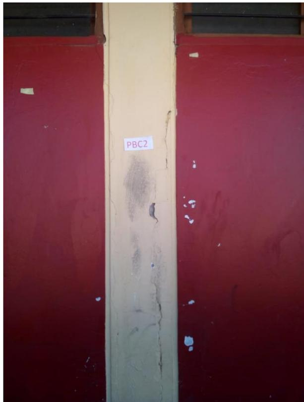
**Imagen N° 22.** Grietas y fisuras en la columna 2° piso del pabellón “D”
