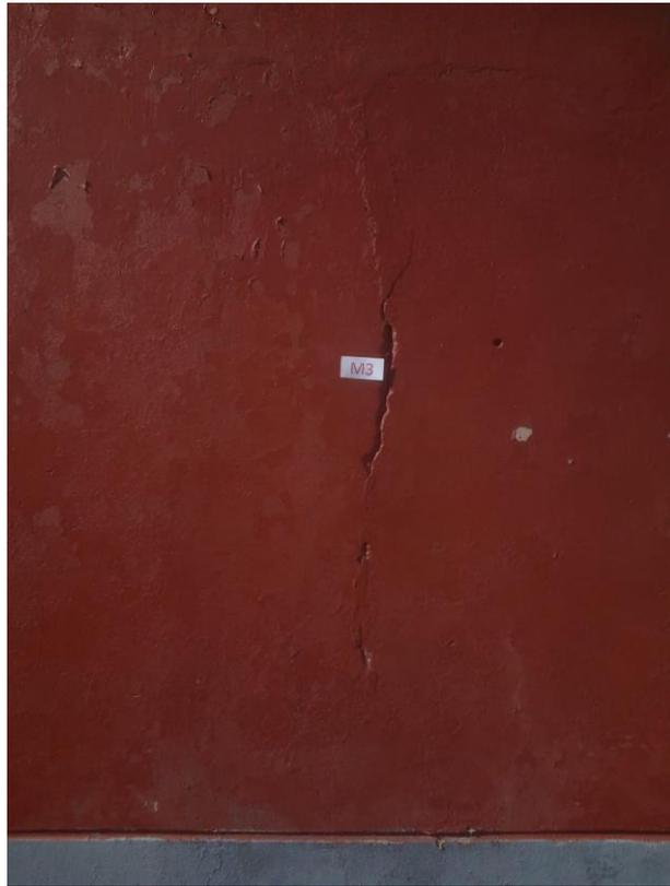
**Imagen N° 13.** Grietas y fisuras del muro – cerco perimétrico lado sur
