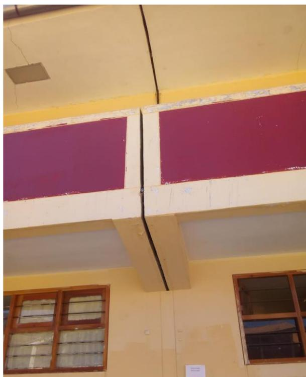
**Imagen N° 16.** Fisuras en las vigas del pabellón “D”
