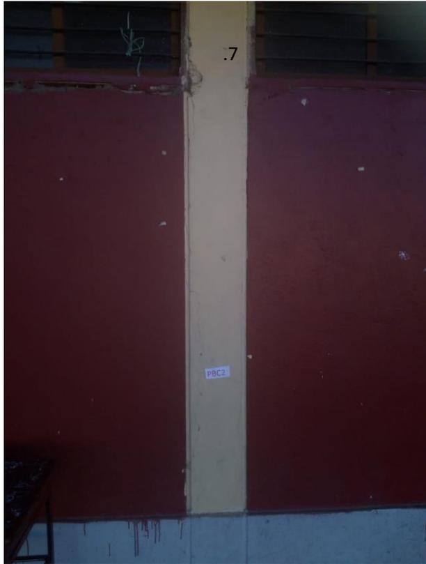
**Imagen N° 9 .** Grietas en la columna y desprendimiento del muro de albañilería P. “B”
