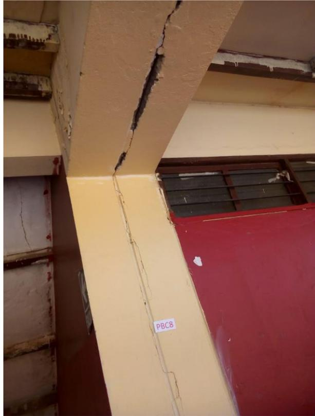
**Imagen N° 19.** Grietas y fisuras en la columna y viga del pabellón “D”
