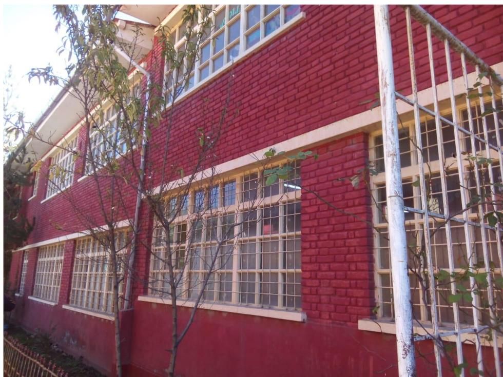
**Imagen N° 40.** Humedad y erosión de sobrecimiento del pabellón “C”
