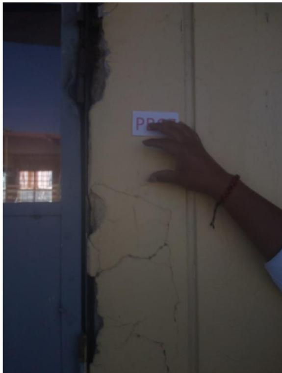
**Imagen N° 12.** Grietas y fisuras en la columna del pabellón "B"
