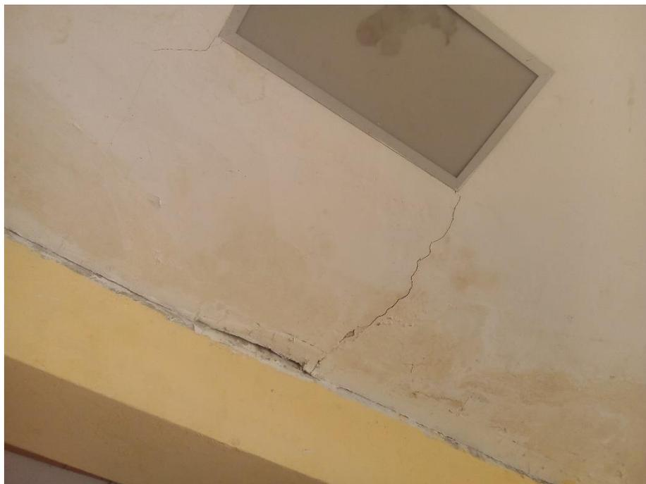
**Imagen N° 15.** Fisuras en la bóveda del techo pabellón “D”
