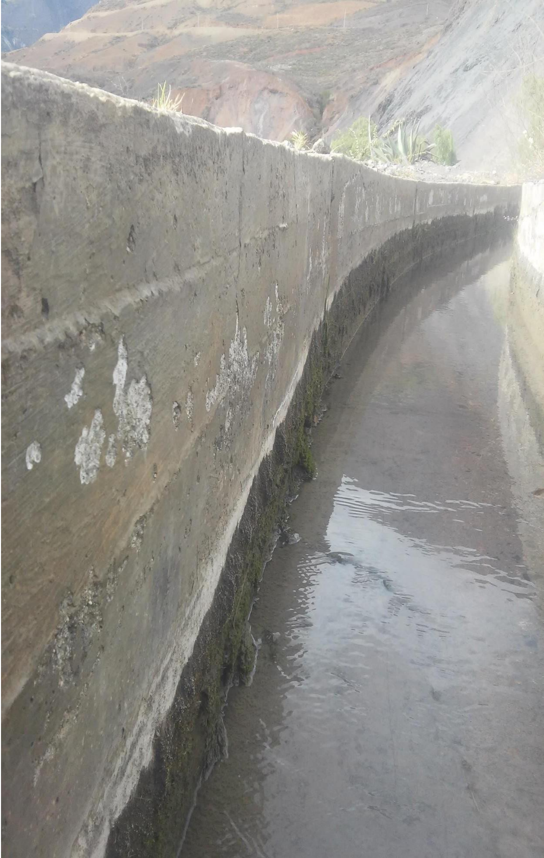
Vista del margen izquierdo de la estructura del canal de riego toma Wiñik. Fuente: elaboración propia, 2021.
