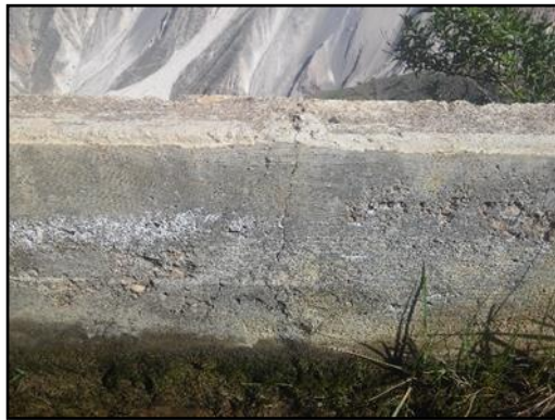
Figura 48: Fotografía de la patología Erosión. Fuente: Elaboración propia, 2021.
