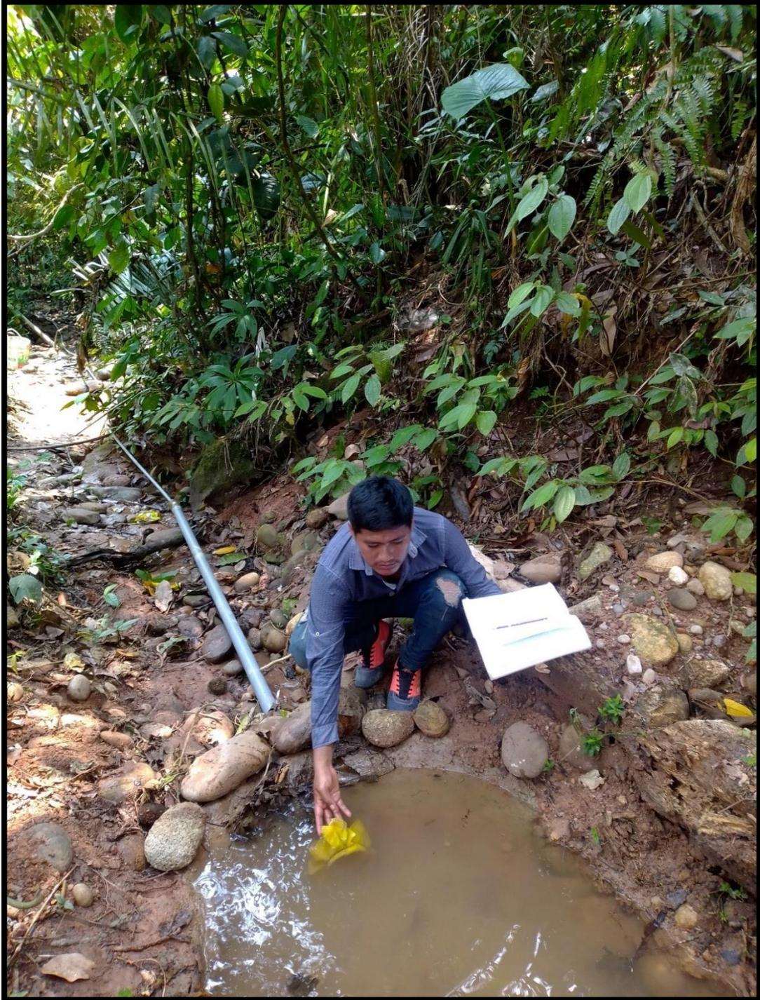
**Figura 10:** captación, filtro y protección de afloramiento artesanal, expuesto al intemperie.
