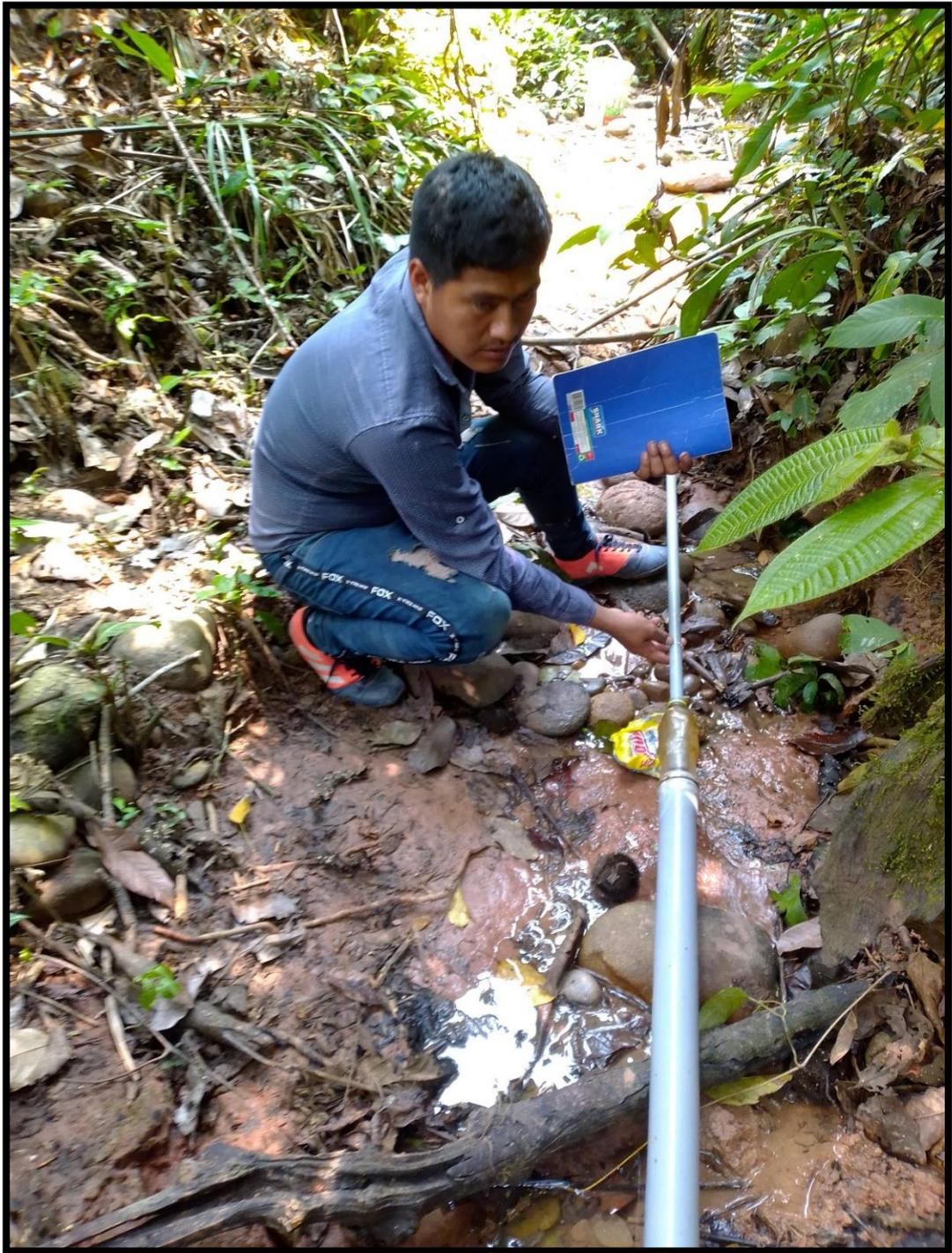
**Figura 11:** Conducción PVC SAP 2" con reducción artesanal a PVC SAP 1/2".
