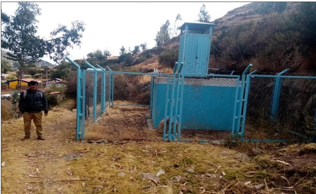
Nota. En la figura tenemos un reservorio existente de 15m<sup>3</sup>, el cual se encuentra en un adecuado estado físico.
