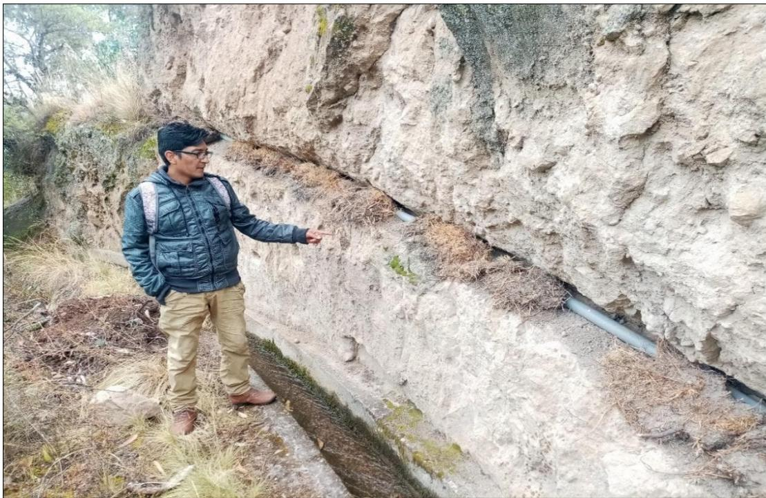
Nota. En esta figura se muestra la línea de conducción de PVC que se encuentra descubierto
