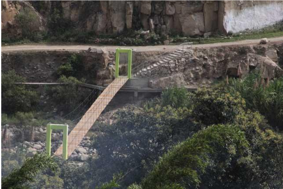
Imagen 01.- Puente colgante del distrito de Poroto.
