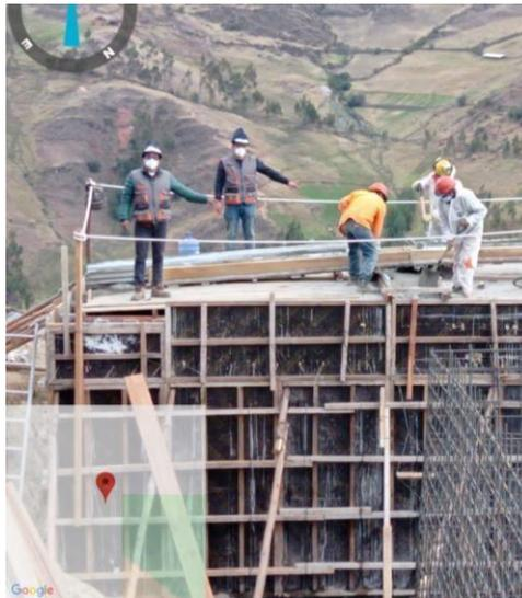
*Nota:* Personal obrero y técnico realizando y supervisando los trabajos de encofrado en altura, respectivamente, sin el equipo de protección adecuado, pone en riesgo a que dicho personal pueda sufrir caídas a desnivel.
