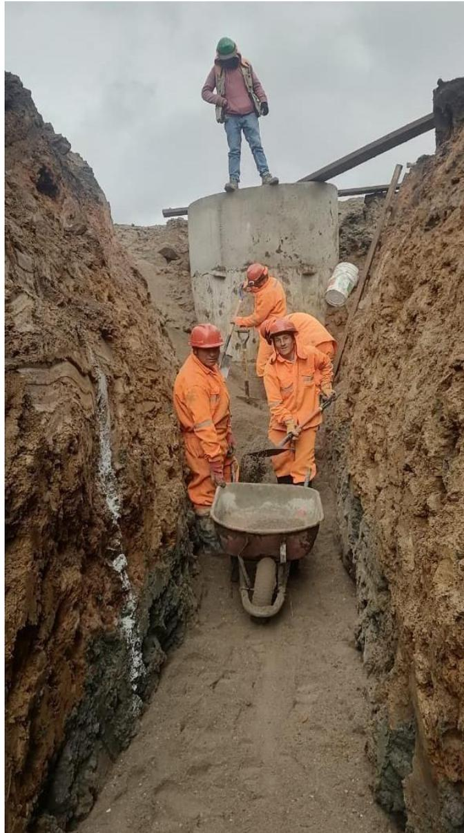
*Nota:* Personal obrero laborando en zanjas que no se encuentran entibadas, pone en riesgo a sufrir lesiones por derrumbes de las paredes laterales. En el año 2021 la empresa realizó en su mayoría obras de saneamiento, por tanto, la excavación de zanjas fue la partida más repetida y la vez la más peligrosa para el personal obrero y técnico, toda vez que estos últimos son quienes realizan la supervisión de la adecuada ejecución.
