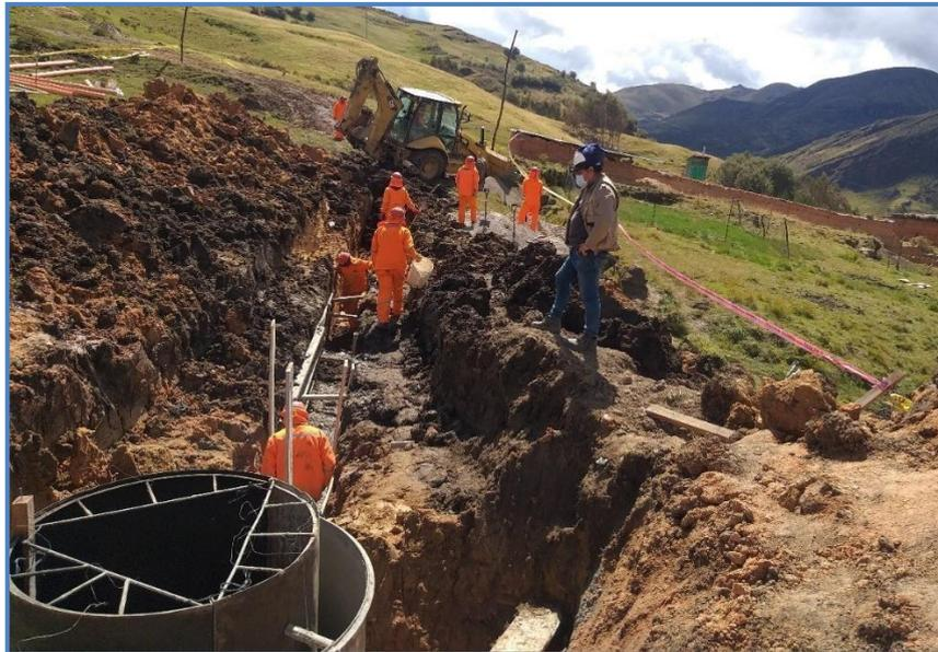
*Nota:* Lo obreros no cuenta con un espacio señalado para su normal tránsito. En la mayoría de frentes de trabajo se ha observado la falta o precaria señalización para el tránsito del personal; en ese sentido, en obras de saneamiento al tener la presencia de excavaciones de zanjas por la falta señalización el personal esta propenso a sufrir caídas a desnivel. De igual manera, estos peligros están presentes para la población aledaña que circula a realizar sus actividades del día.
