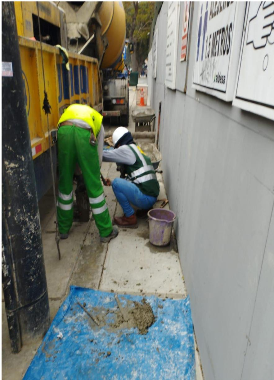
**Revisión del Slump del Concreto para ver la trabajabilidad del concreto
