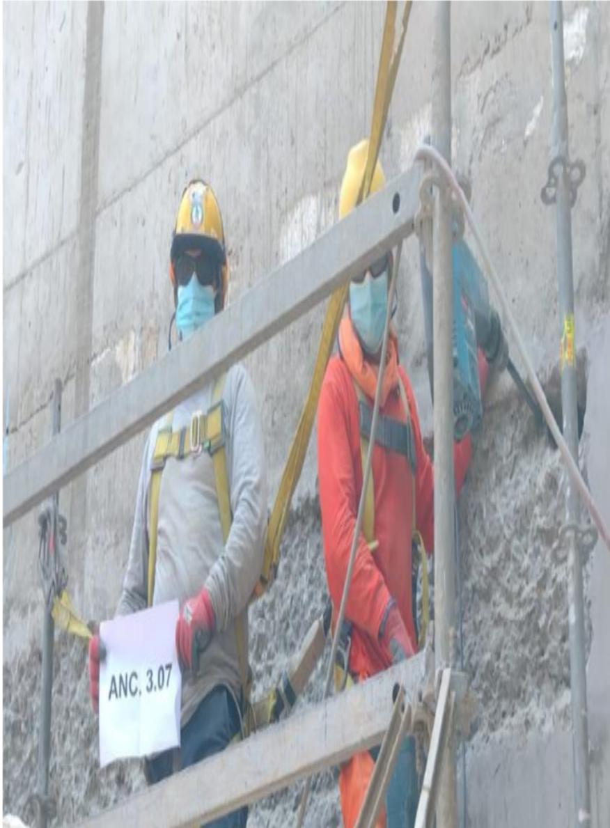
**Reparaciones de elementos estructurales por vaciados de concreto incorrecto**
