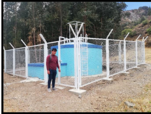
Imagen 05: Cámara Rompe Presión Tipo 6 y Trasvase.
