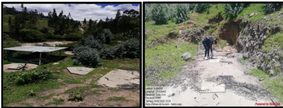
Imagen 11: Planta de tratamiento.
