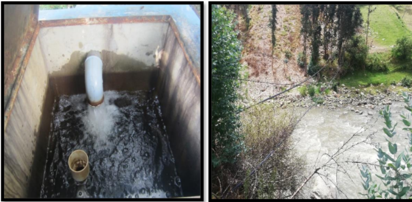
Imagen 05: Cámara Rompe Presión Tipo 6 y Trasvase.
