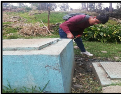
Imagen 02: Captación de agua CAP-02
