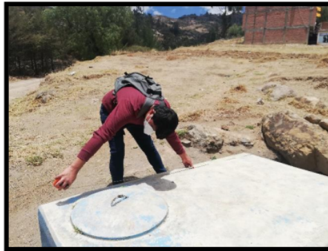
Imagen 08: Válvula reguladora de Presión VRP.
