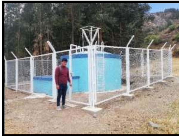
Imagen 05: Cámara Rompe Presión Tipo 6 y Trasvase.
