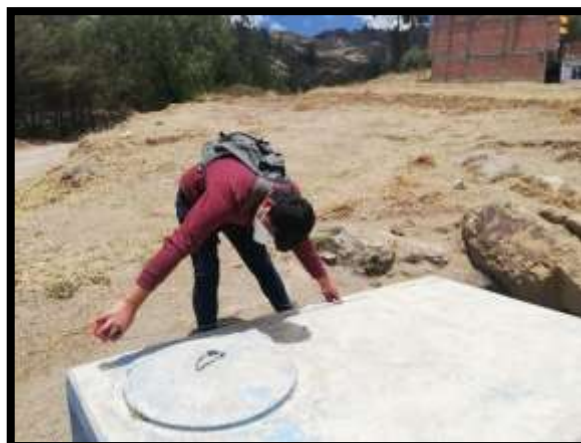
Imagen 08: Válvula reguladora de Presión VRP.
