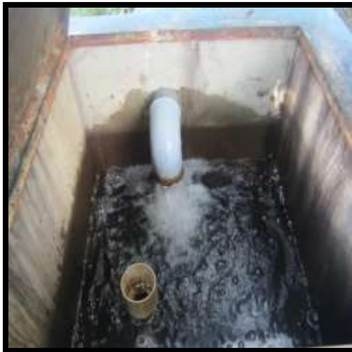
Imagen 05: Cámara Rompe Presión Tipo 6 y Trasvase.
