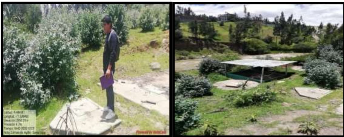
Imagen 14: Cámara de Distribución.
