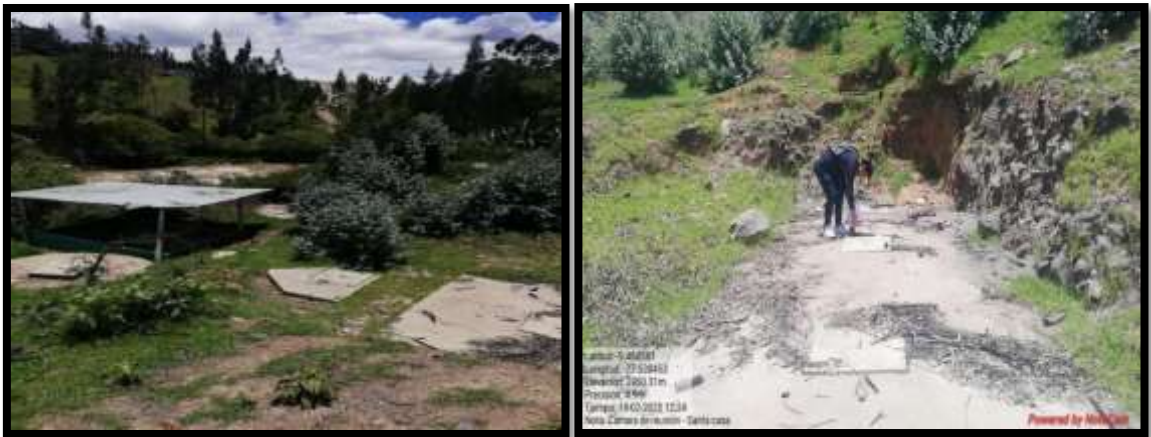
Imagen 11: Planta de tratamiento.
