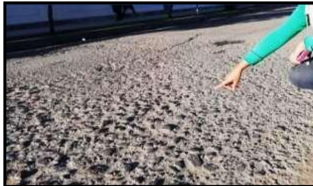
Figura 12. Pulimento de la superficie. Fuente: elaboración propia.
