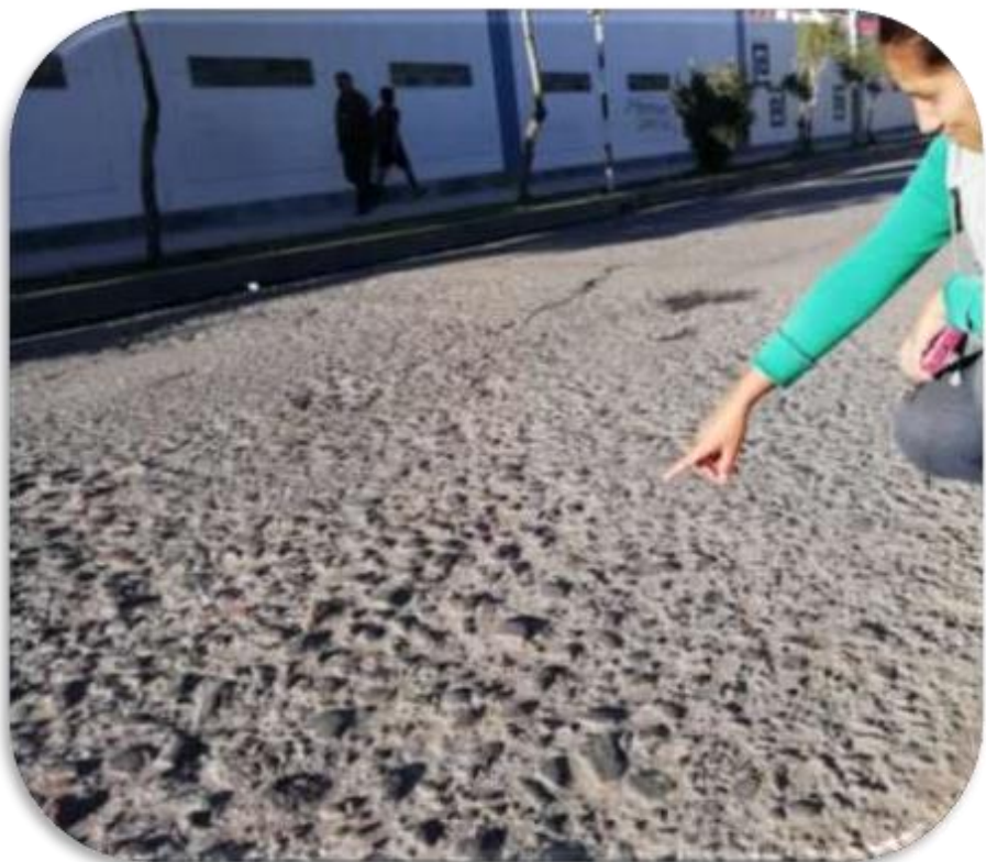
FOTOGRAFIA 4 Pulimiento de la Superficie
