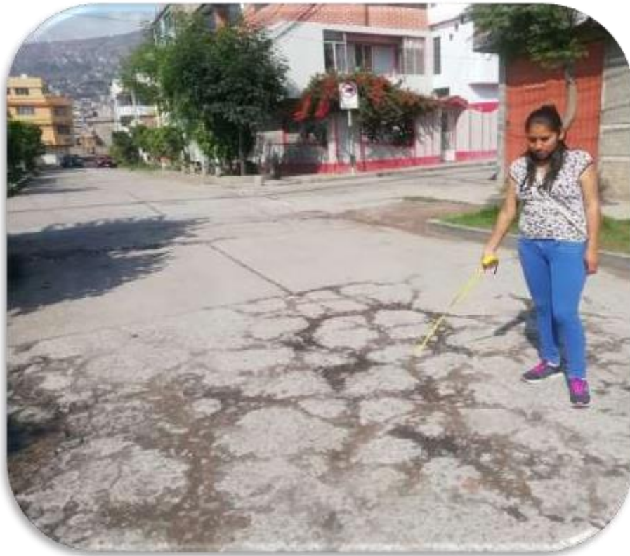
FOTOGRAFIA 7 losa subdivididas.
