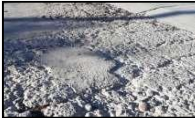
Figura 9. Losas subdivididas.
