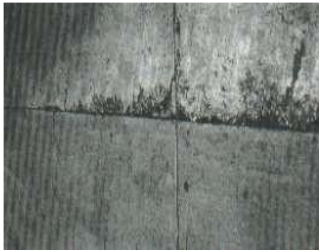
Figura 15. Descascaramiento de junta. Fuente: Manual de pavement condition index (PCI)(23)
