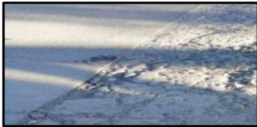
Figura 10. Levantamiento de losas. Fuente: elaboración propia.
