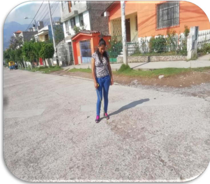
FOTOGRAFIA 5 Fisuramiento debido a cargas en la UM-02.
