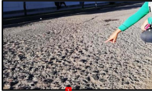
Figura 12. Pulimento de la superficie. Fuente: elaboración propia.
