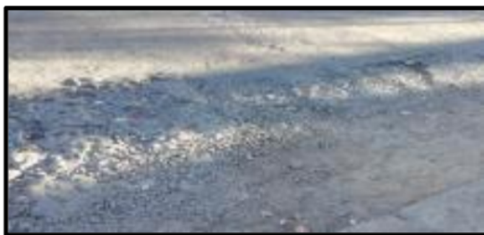
Figura 11. Hundimiento Fuente: elaboración propia.
