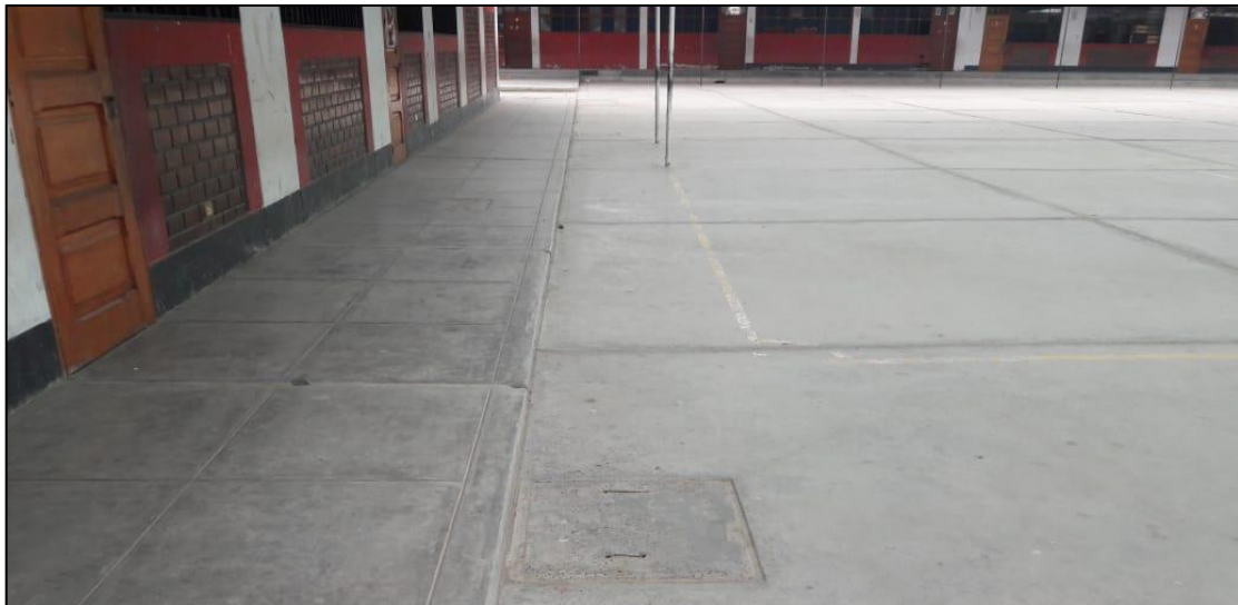
Fotografía N° 04. Vista lateral izquierdo del patio central, donde se proyectará la instalación de estructura metálica con cobertura con malla Raschel 2020.
