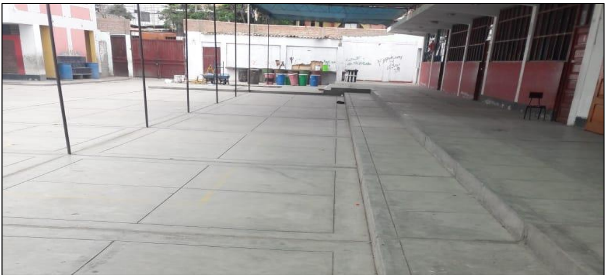
Fotografía N° 06. Se observa la parte trasera del patio central donde se demolerá parte de concreto para realizar la cimentación de la estructura metálica para cobertura con malla Raschel 2020.
