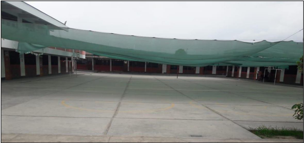
Fotografía N° 03. Vista del patio central, donde se proyectará la instalación de estructura metálica, para cobertura con malla Raschel. Así mismo se la instalación de malla Raschel instalada completamente inestable 2020.
