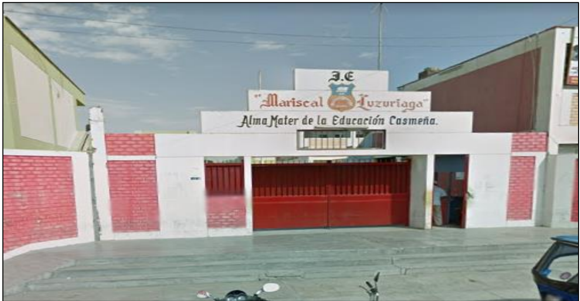
Fotografía N° 01. Se observa la entrada principal para los alumnos de nivel secundario de la I.E. Mariscal Luzuriaga, al interior de la entrada principal se realizará la ejecución de una pequeña cobertura metálica con malla Raschel 2020.
