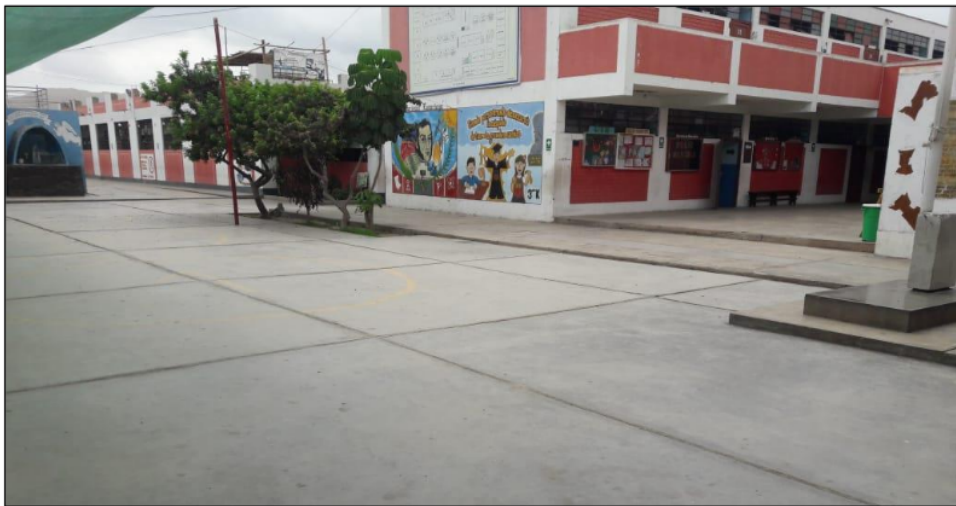
Fotografía N° 02. Vista del ancho del Patio de la I.E. Mariscal Luzuriaga, donde se proyecta la estructura metálica para cobertura con malla Raschel 2020.
