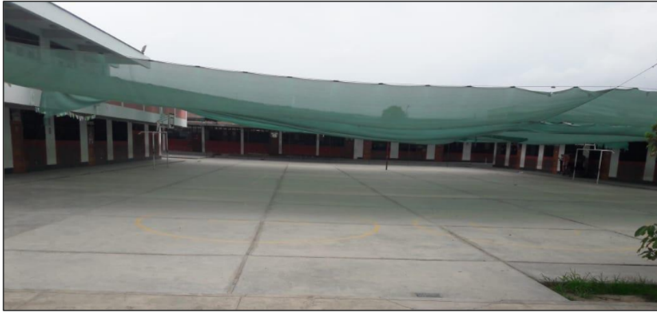
Fotografía N° 03. Vista del patio central, donde se proyectará la instalación de estructura metálica, para cobertura con malla Raschel. Así mismo se la instalación de malla Raschel instalada completamente inestable 2020.
