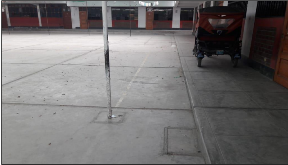
Fotografía N° 05. Vista lateral derecho del patio central, donde se proyectará la instalación de estructura metálica con cobertura con malla Raschel. Se observan parantes metálicos con su respectiva cimentación 2020.
