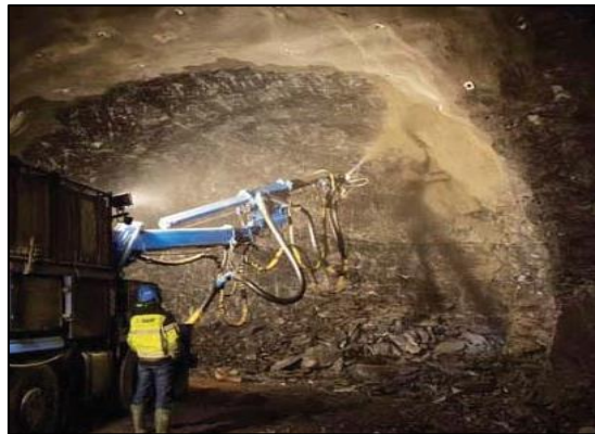
FIGURA N° 14. Lanzado de Shocrete con distancia adecuada
