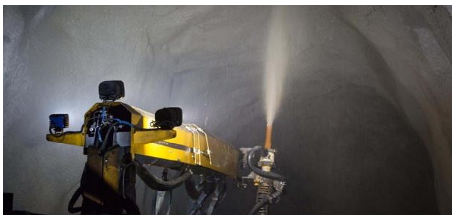
FIGURA N° 12. Lanzado de Shocrete
