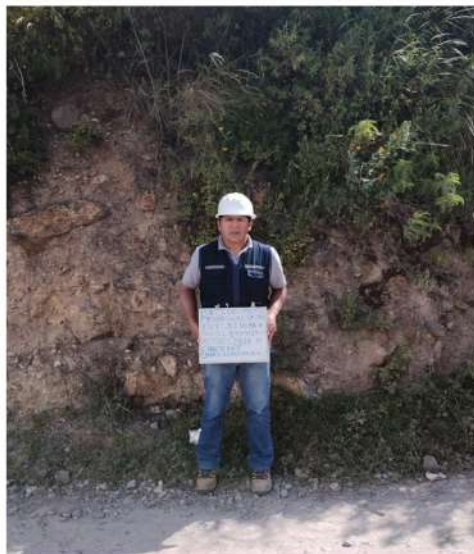
Punto de Corte transversal S3 del talud
