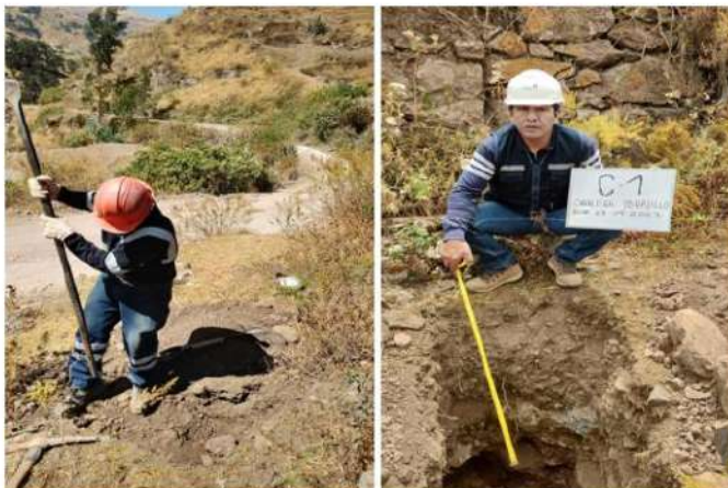
Excavación de calicata 01 para estudio 1 de mecánica de suelos
