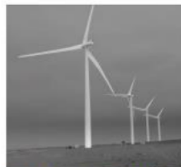
Figura 1. Parque eólico en Marcona.
