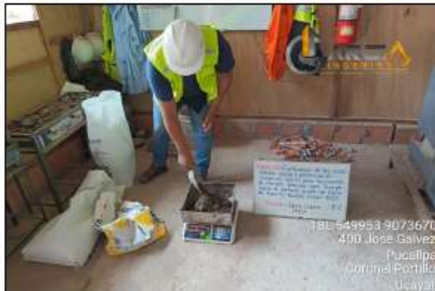
FOTO 23: SE OBSERVA EL PESO DEL CEMENTO
