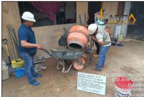
FOTO 25: SE OBSERVA LA MEZCLA PARA EL MOLDEO DE ADOQUINES
