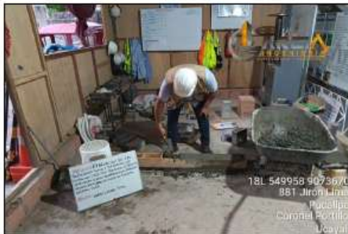
FOTO 27: SE OBSERVA AL TESISTA CONTINUANDO CON EL MOLDEO DE LOS ADOQUINES
