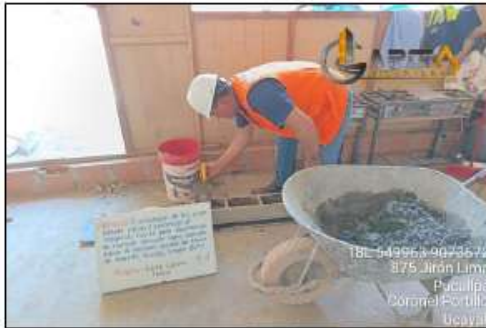
FOTO 29: MOLDEO DE LOS ADOQUINES
