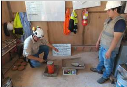
FOTO 19: SE OBSERVA EL ENRASADO DEL MOLDE
