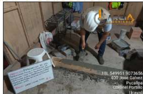
FOTO 28: MOLDEO DE LOS ADOQUINES
