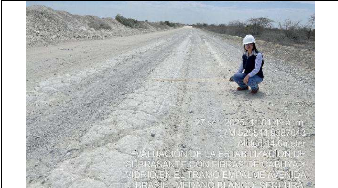
FOTO 04: La imagen evidencia un tramo con enclaminado, las vías sin pavimentar han sufrido una erosión por el tráfico continuo y las condiciones climáticas.
