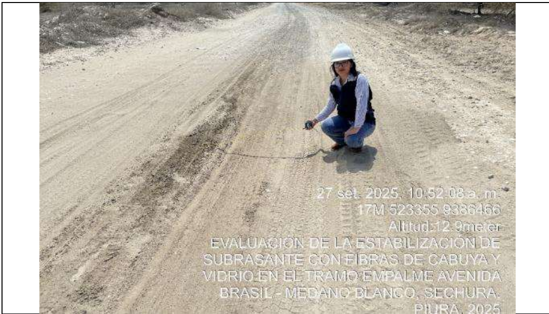
FOTO 03: La imagen muestra una falla por ahuellamiento, causados por el paso repetido de vehículos, principalmente por camiones de carga.
