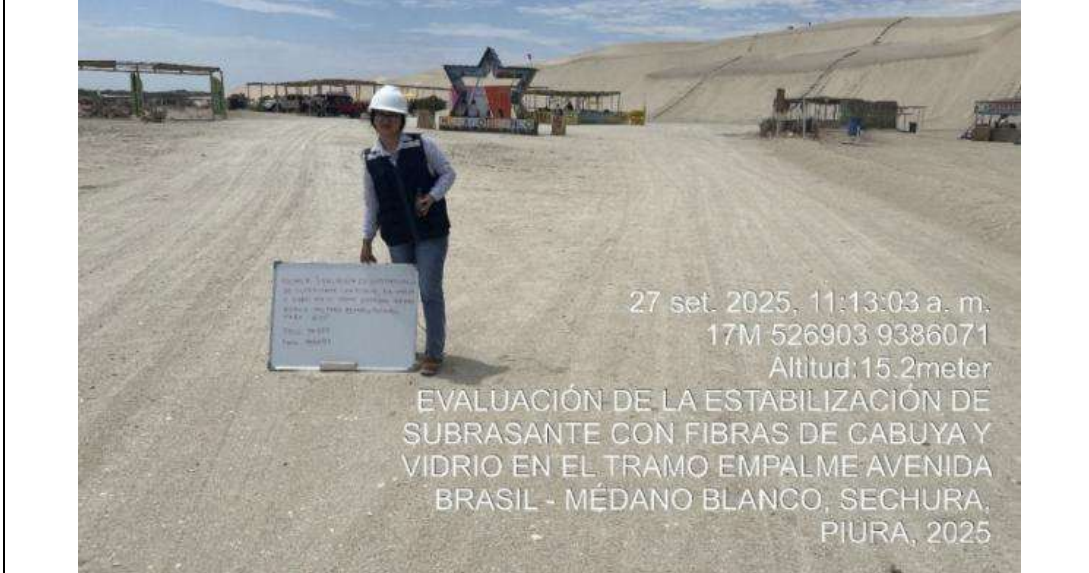
FOTO 06: Se termina el recorrido del tramo en la progresiva 7+220
