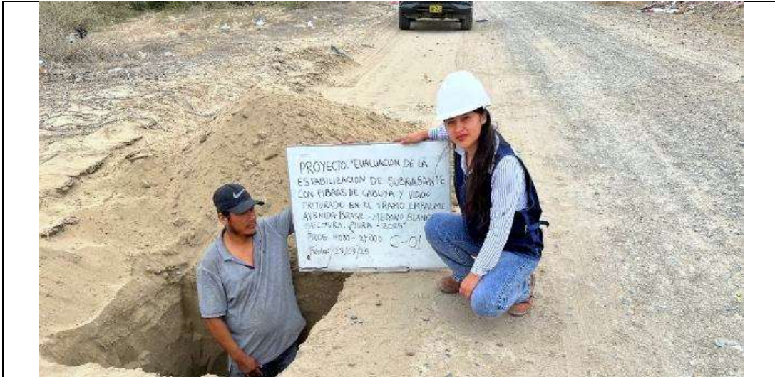
FOTO 08: Se extrae las muestras de la C-01, progresiva 1+000–2+000.
