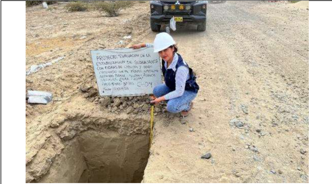
FOTO 11: Se extrae las muestras de la C-04, progresiva 4+000–5+000.
