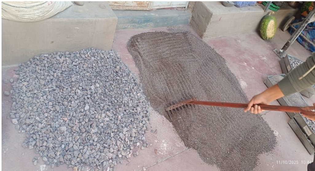
FOTO 09: Secado de los agregados
