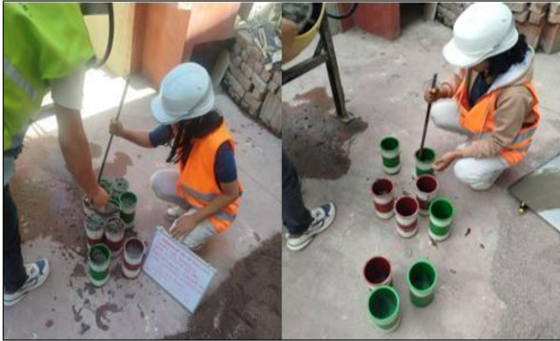
FOTO 15: Llenado y compactado del concreto
