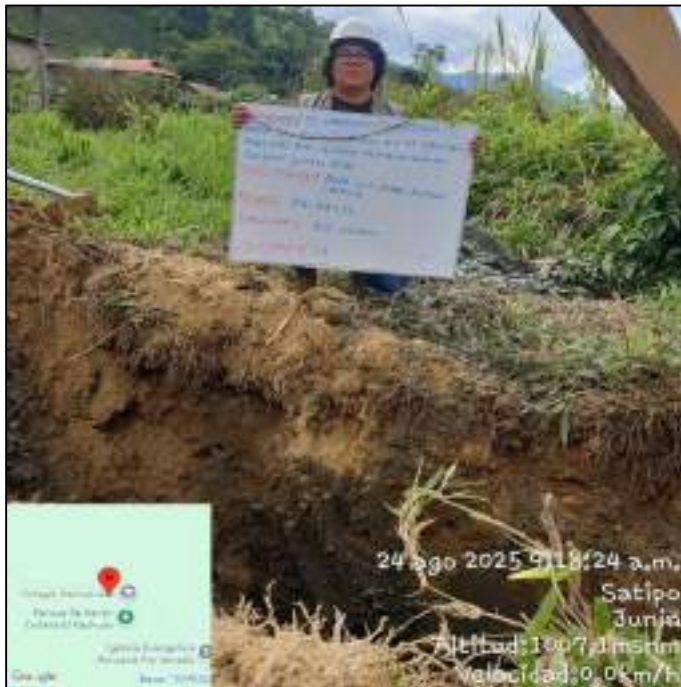
Calicata N° 01 en el Centro Poblado Río Venado
