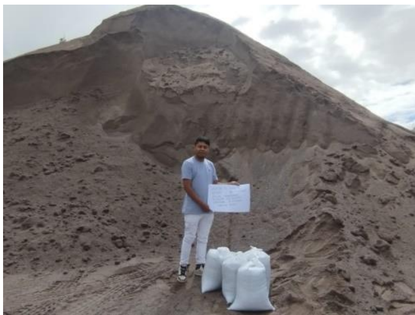
FOTO 02: Extracción del agregado fino en la cantera de “La Moderna” en la zona de Chillico.
