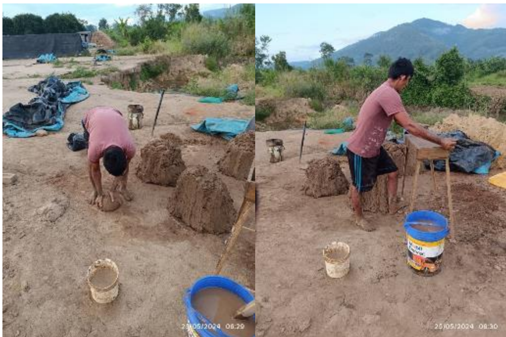
Ilustración 24- Moldeado de la mezcla
