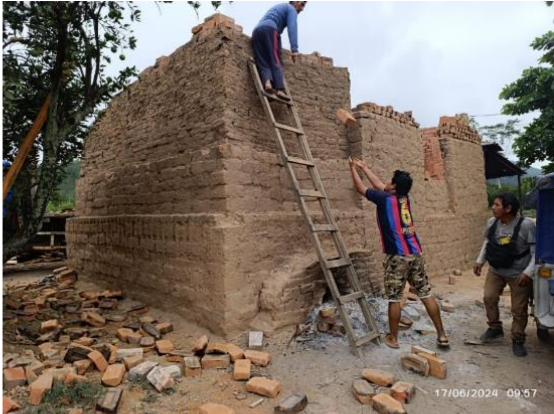
Ilustración 31- Retiro y transporte del ladrillo al Laboratorio
