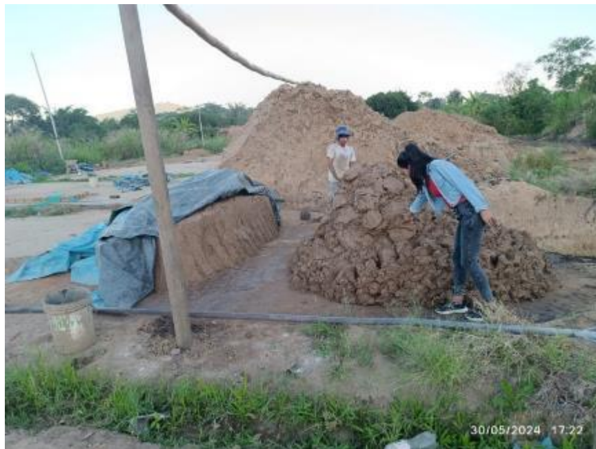
Ilustración 22- Refinación de la mezcla
