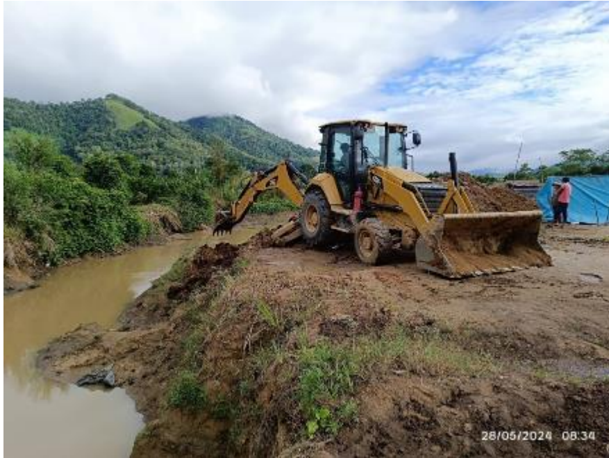
Ilustración 19- Extracción de material con Cargador Frontal
