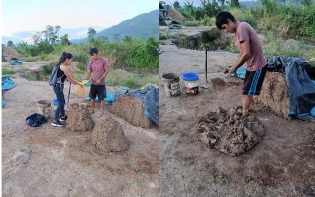
Ilustración 23- Adición de la fibra de cascara de coco a la mezcla
