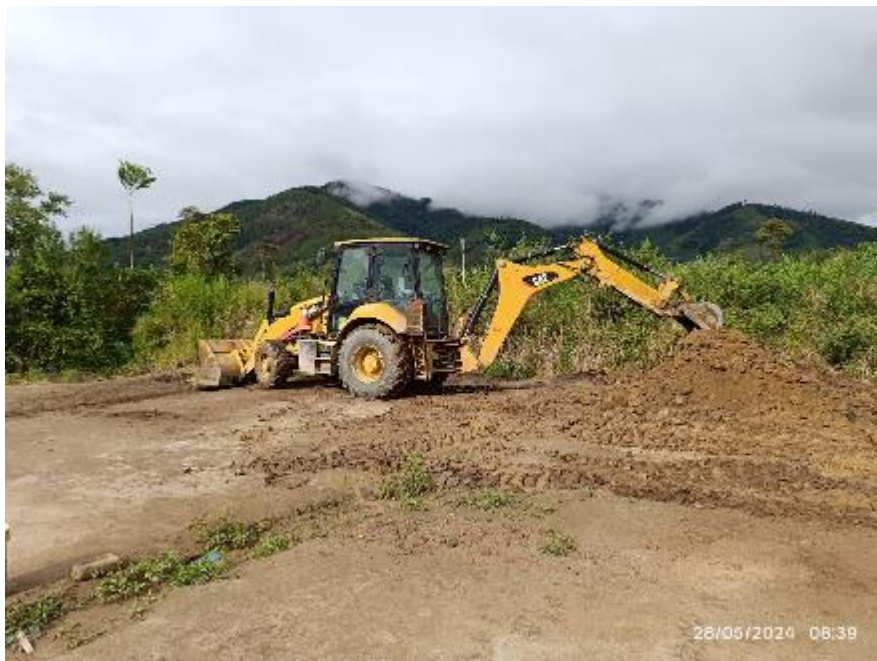
Ilustración 20- Apilamiento de material con Cargador Frontal
