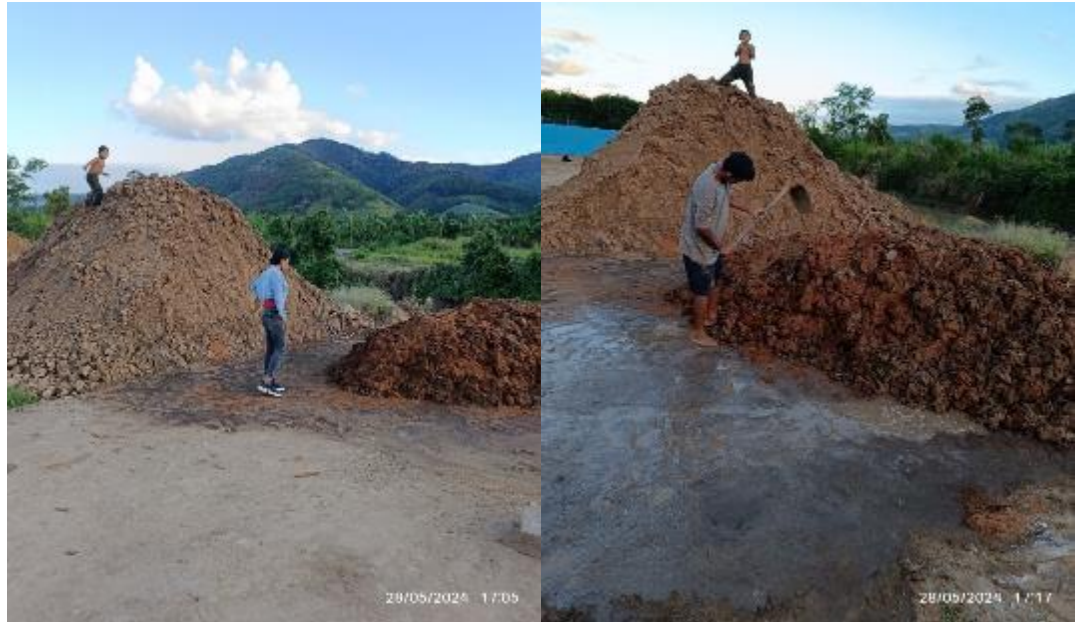
Ilustración 21- Separación, eliminación de impurezas de la mezcla
