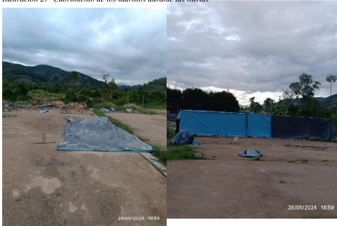
Ilustración 27- Cubrimiento de los ladrillos durante las lluvias
