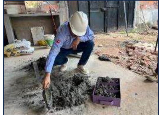
Vaciado de mezcla en molde según dosificación
