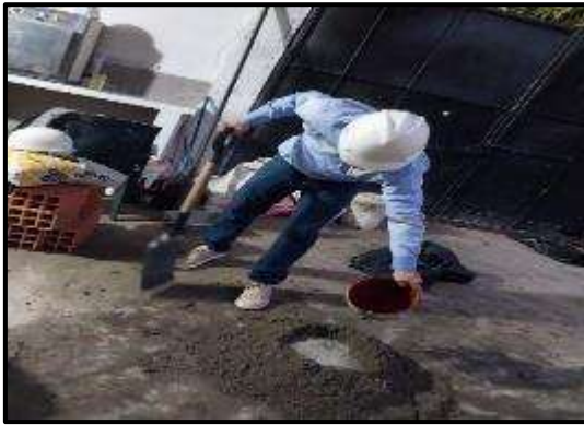
Mezcla de materiales para elaboración de ladrillos
