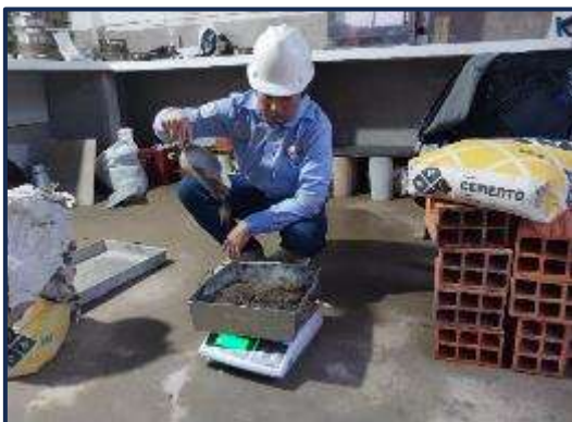
Pesado del agregado fino según dosificación
