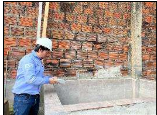
Ladrillo de concreto sumergido en recipiente para periodo de curado
