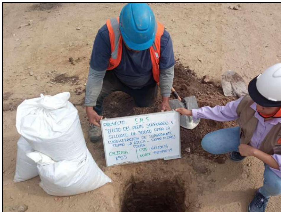
Evidencia Fotográfica N°06: Realización de la toma de muestra de la calicata N°03
