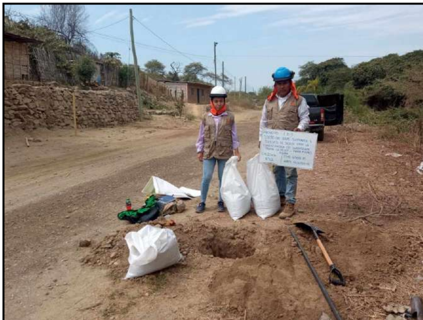
Evidencia Fotográfica N°03: Realización de la toma de muestra de la calicata N°02
