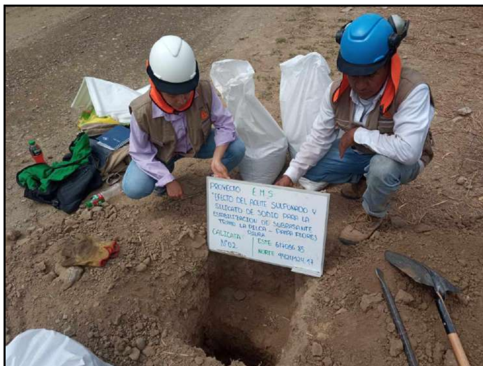
Evidencia Fotográfica N°04: Realización de la toma de muestra de la calicata N°02
