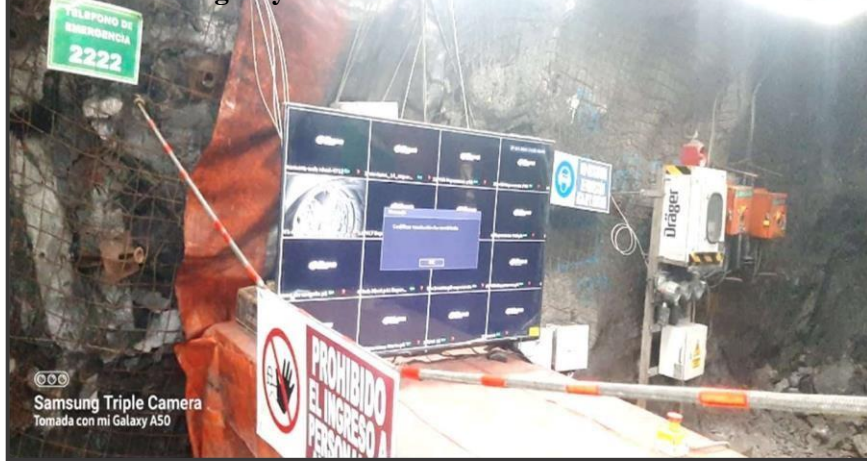
Puestos de vigías y visualización de cámaras de las ventanas de explotación.
