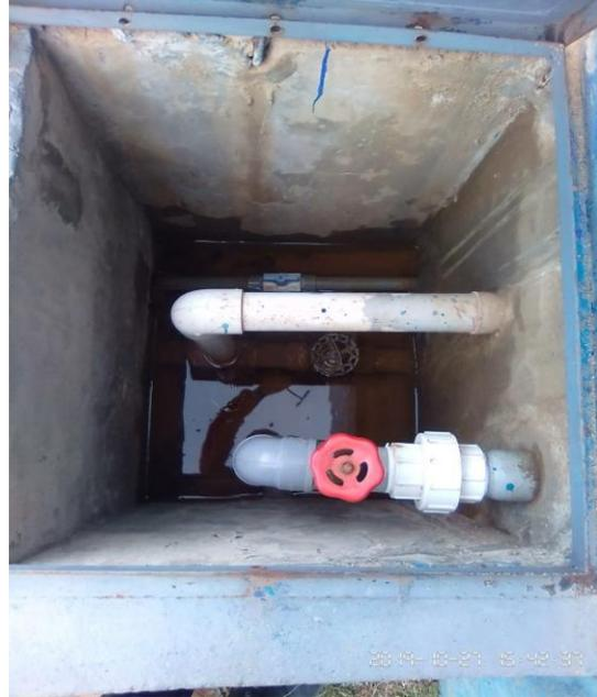
**Fotografía N° 03:** Caja de válvulas de control, se encontró una válvula sin unión universal y presencia de agua que está oxidándola.
