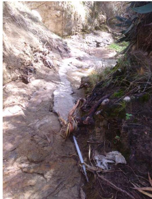
**Fotografía N° 12:** Captación de CARHUAIN, se encontró tuberías expuestas.
