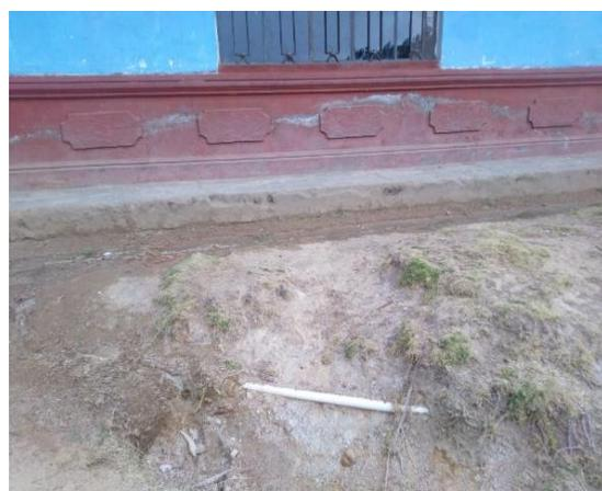
**Fotografía N° 14:** Línea de conducción, se encontró tuberías expuestas a la intemperie.
