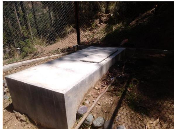
**Fotografía N° 15:** Planta de tratamiento de aguas residuales, cámara de rejilla para dar el tratamiento preliminar, tratamiento primario tanque séptico con 3 tapas de concreto se encuentra en buen estado todo el sistema.
