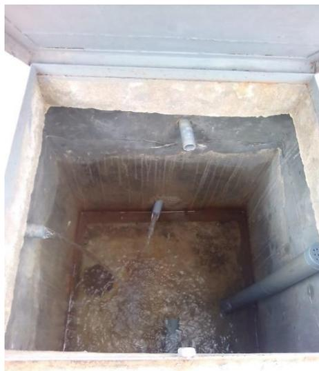
**Fotografía N° 13:** Línea de conducción, cámara de reunión de las captaciones de CARHUAIN Y MINTUJIRCA, el interior cuenta con canastilla de salida, ventilación, pero no cuenta con válvulas la instalación es directa, la tapa metálica presenta oxidación en algunas partes.
