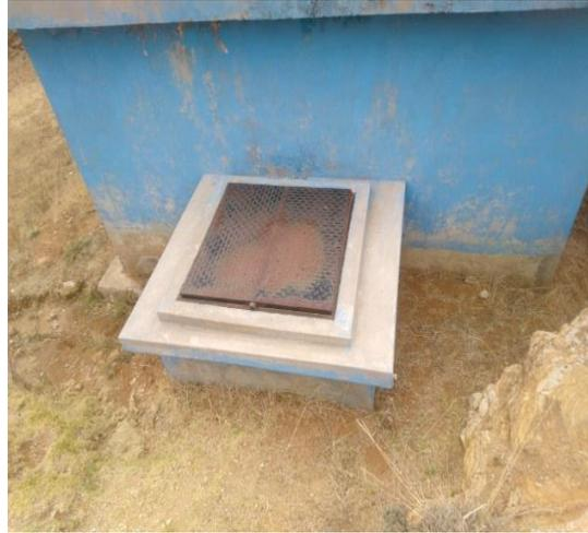
**Fotografía N° 05:** Reservorio 1 las tapas del reservorio y la caja de válvulas de control se encuentran oxidadas.
