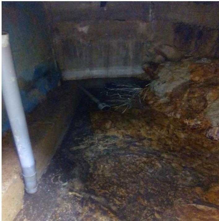
**Fotografía N° 08:** Captación de MINTUJIRCA el interior cuenta con canastilla de salida, ventilación, pero no cuenta con válvulas la instalación es directa.
