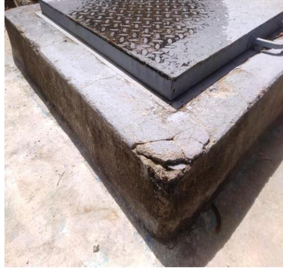
**Fotografía N° 08:** Captación de MINTUJIRCA se encontraron fisuras y desprendimiento del revestimiento por no contar con un cerco perimétrico adecuado para su protección de la estructura.
