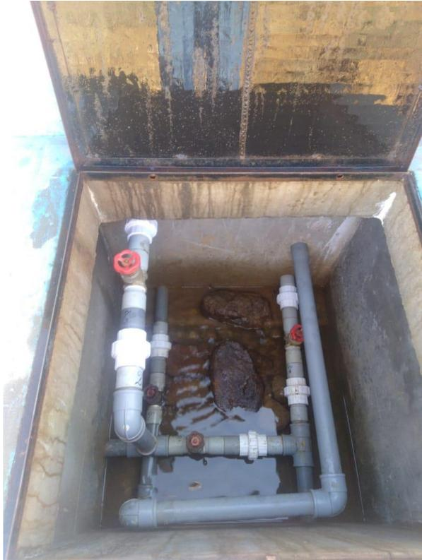
**Fotografía N° 06:** Caja de válvulas de control, se encontró válvulas en estado de oxidación con presencia de agua y piedras al interior.
