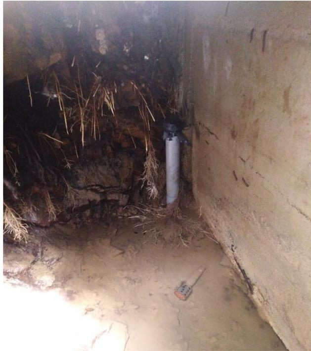
**Fotografía N° 11:** Captación de CARHUAIN el interior cuenta con canastilla de salida, ventilación, pero no cuenta con válvulas la instalación es directa.
