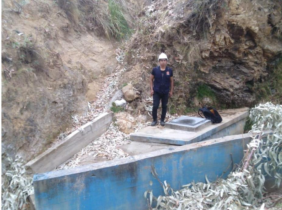
**Fotografía N° 07:** Captación de MINTUJIRCA el cerco perimétrico no es el adecuado y se encontró maleza.
