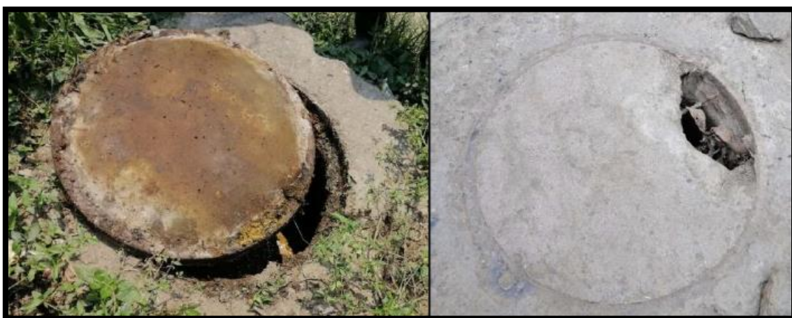
Fotografía 11: Buzones deteriorados.
