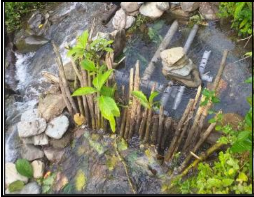
Fotografía 2: Captación existente.
