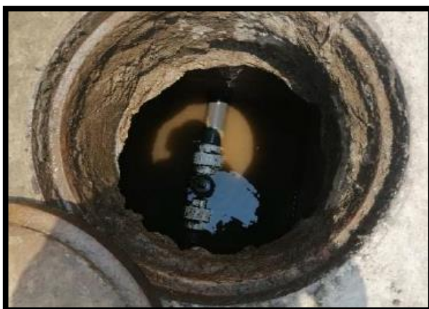
Fotografía 8: Valvulas de contros deteriorados.
