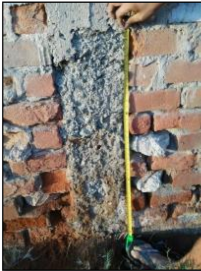
Figura 11: Desintegración.
