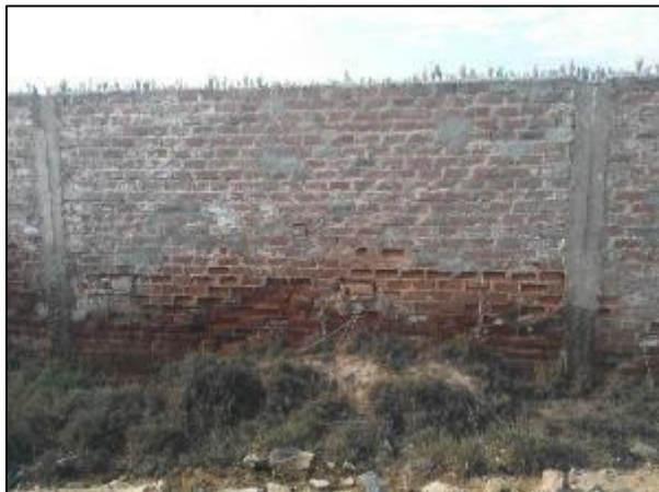
Figura 22: Patología erosión.
