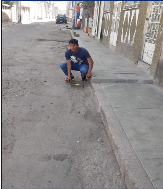
Fotografía N° 05: patología grieta de borde, severidad media Fuente: Elaboración propia.
