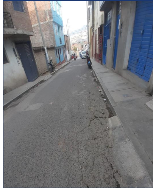
Fotografía N° 05: patología grieta de borde, severidad media Fuente: Elaboración propia.
