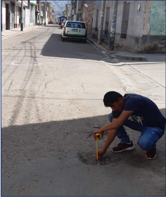
Fotografía N° 01: patología hallada huecos, nivel de severidad bajo. Fuente: Elaboración propia.
