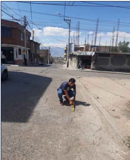
Fotografía N° 04: patología grieta longitudinal, severidad media y alta Fuente: Elaboración propia.
