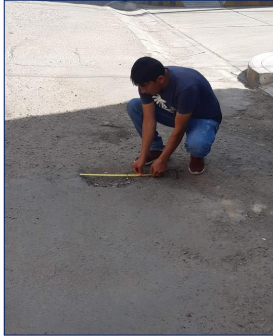
Fotografía N° 01: patología hallada huecos, nivel de severidad bajo. Fuente: Elaboración propia.
