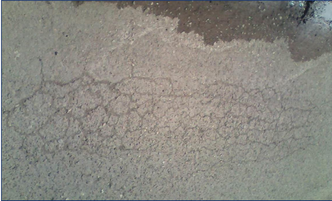
Fotografía N° 03: patología hallada piel de cocodrilo, severidad media Fuente: Elaboración propia.
