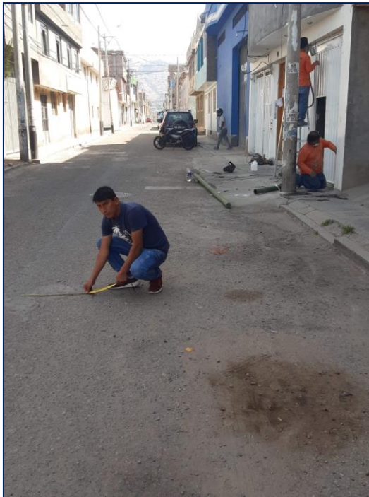
Fotografía N° 06: patología depresiones, severidad media Fuente: Elaboración propia.
