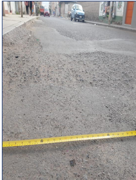
Fotografía N° 06: patología depresiones, severidad media Fuente: Elaboración propia.
