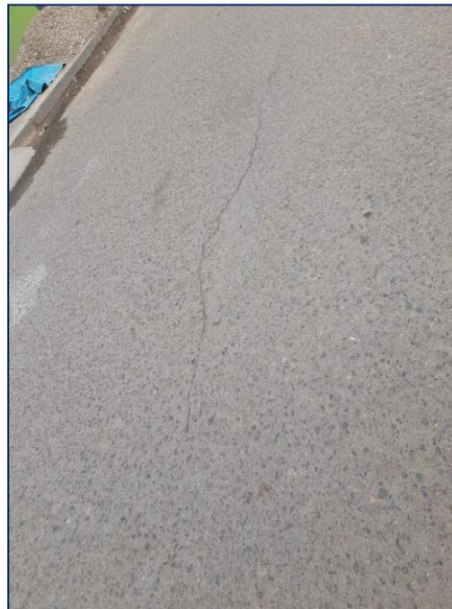
Fotografía N° 04: patología grieta longitudinal, severidad media y alta Fuente: Elaboración propia.
