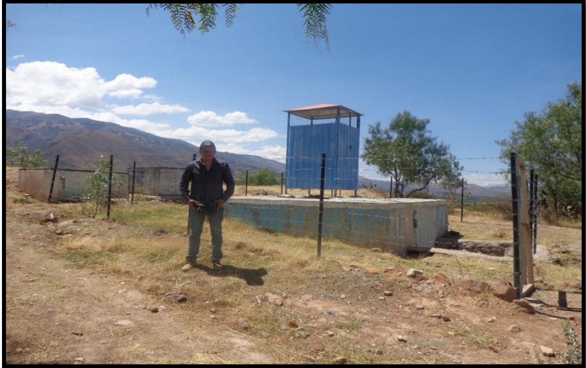
Figura N° 6: En el reservorio de la localidad de Aicas Fuente: Elaboración propia
