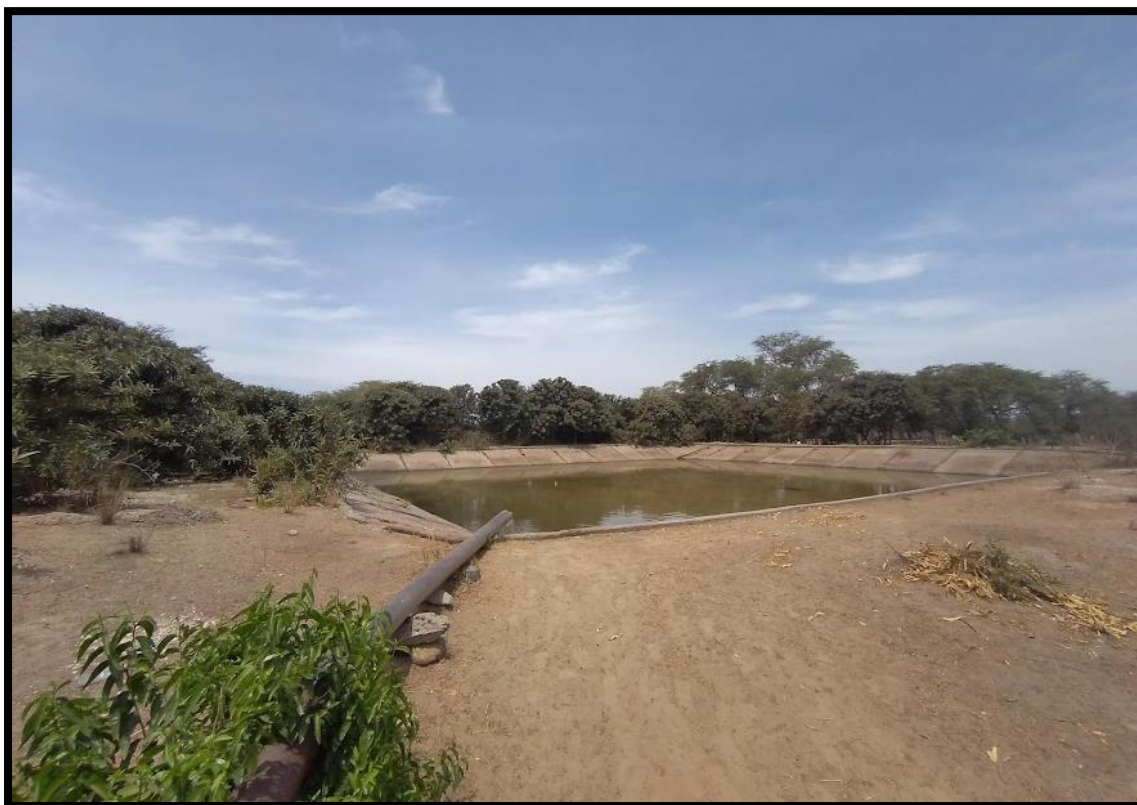
Imagen 8. Fuente de almacenamiento de agua, la cual luego distribuye a los bebederos.
