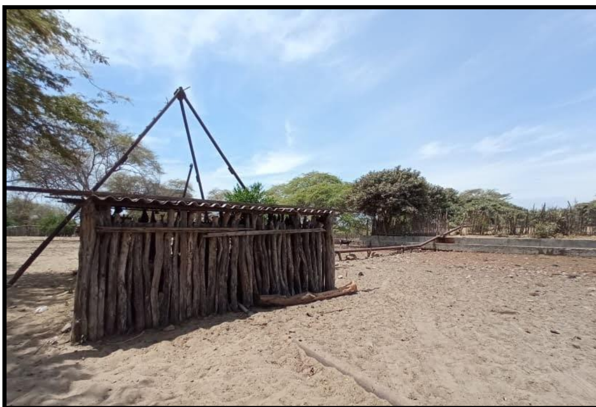
Ilustración 1 Caseta De Bombeo
