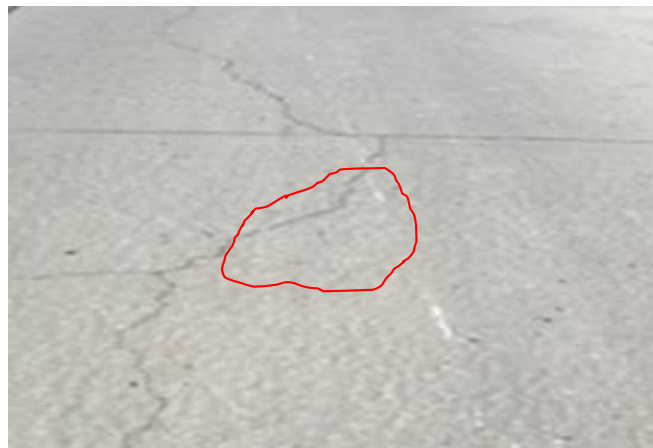
Imagen 4 Grietas longitudinales
