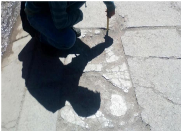
Imagen 10 Descascaramientos
