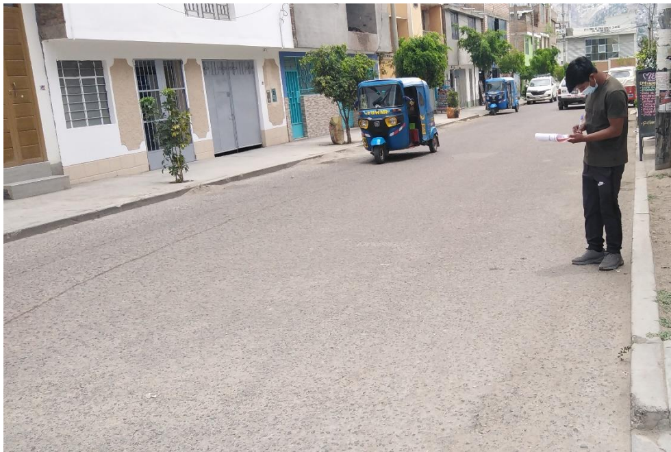
Imagen 16 Pulimiento de agregados , José Carlos Mariátegui
