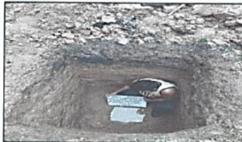
SATURACION DL POZO PERCOLARDOR
