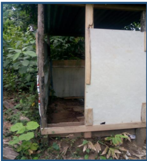
IMAGEN 5: Baño existente en del Caserío Nuevo Ucayali.
