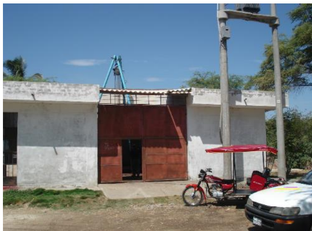
Figura 7 Pozo San Carlos
