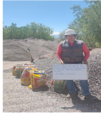
Extracción de la arena gruesa
