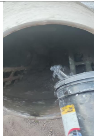
Adición de agua en la mezcla de concreto
