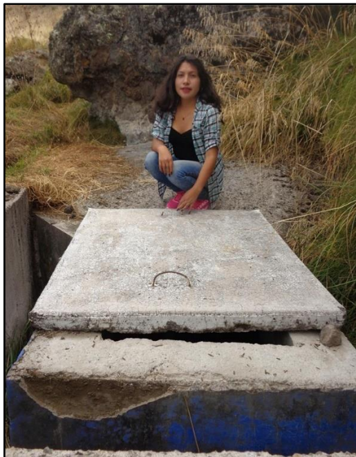
Fotografía N° 08. Se visualiza a la bachiller Yasmin Yshuly De La Cruz Sánchez en la cámara de captación del caserío Aguiñuay.
