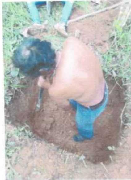
Foto N°01: Vista de la calicata C-1 Captación
