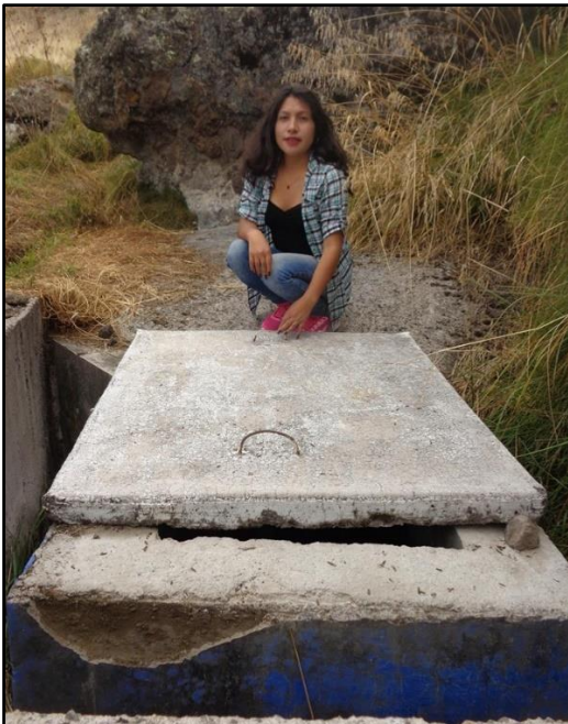
Cámara de captación del caserío Aguiñuay
