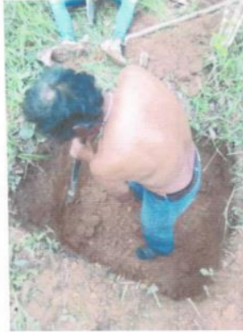
Foto N°01: Vista de la calicata C-1 Captación
