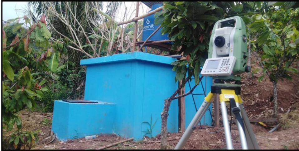
Fotografía N° 01. Se visualiza el equipo técnico con los instrumentos necesarios para el levantamiento topográfico.
