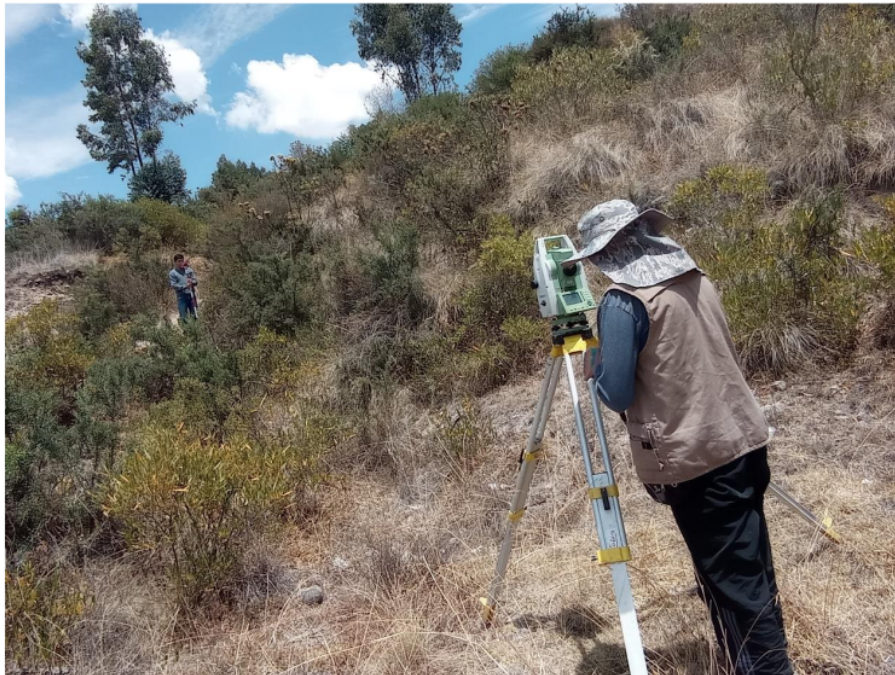
Fotografía 12. Levantamiento topográfico (línea de distribución)
