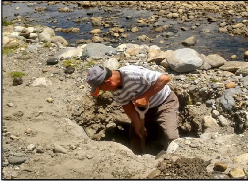
Realizando calicata N°1
