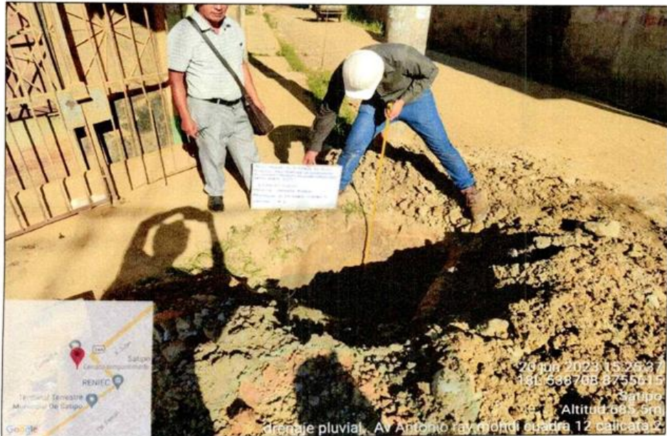
MUESTREO DE LA EXCAVACION DE LA CALICATA 2 DEL DRENAJE PLUVIAL DE LA AV. RAYMONDI CUADRA 12
