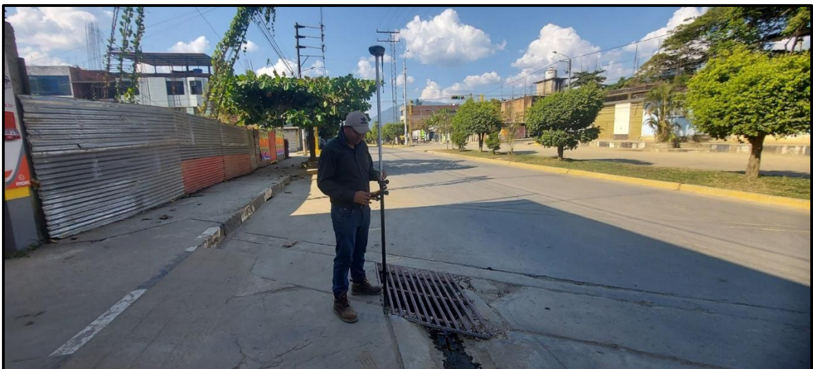
Fotografía N° 04. Se observa al tesista Angelo Alexander Castañeda Hinostroza realizando el levantamiento topográfico en el único sumidero de drenaje pluvial en la avenida Raymondi el 15 de julio del 2023.
