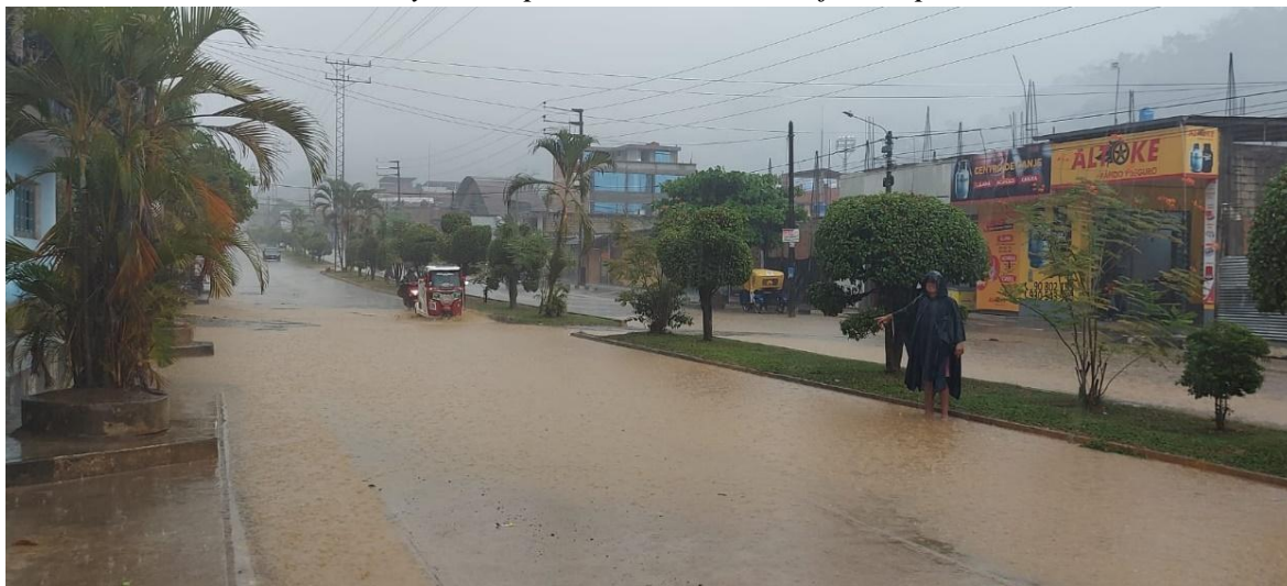
Inundación de la avenida Raymondi por sistema de drenaje colapsado
