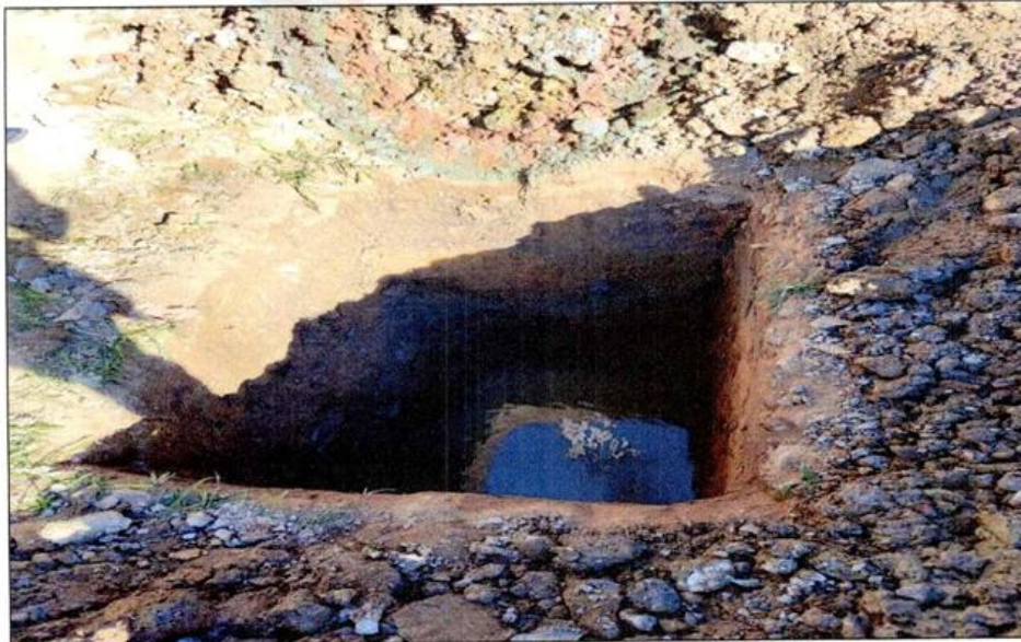
EXCAVACION DE LA CALICATA 2 DEL DRENAJE PLUVIAL DE LA AV. RAYMONDI CUADRA 12
