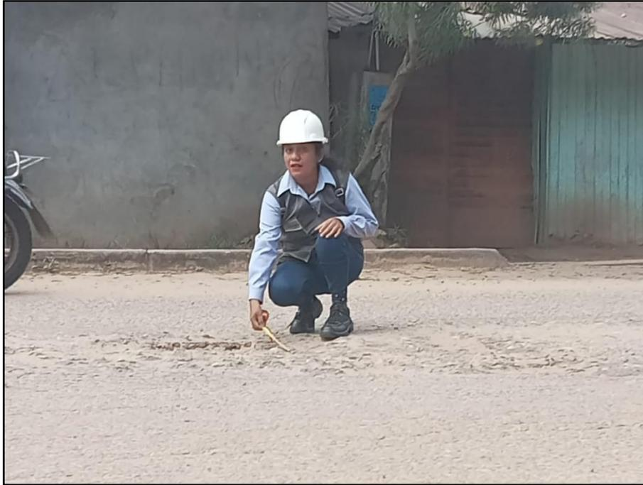
Fotografía N° 01. Uso PCI “Índice de Condición de Pavimento” para definir las patologías de la Av. Salvador Allende.
