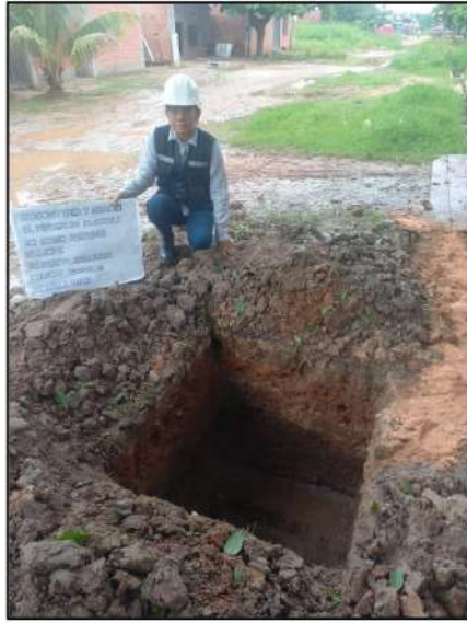
Fotografía N° 03. Obtención de la muestra de suelo en la excavación N° 01.
