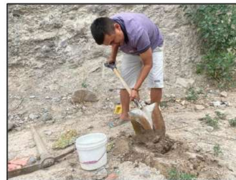
Fotografía 8: Mezclado de la tierra, fibra de penca, y paja
