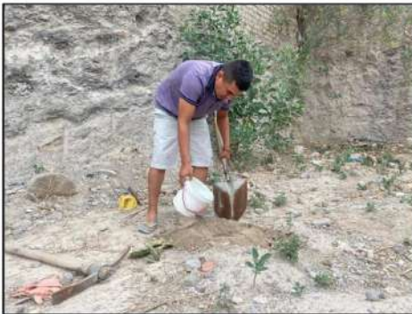
Fotografía 8: Mezclado de la tierra, fibra de penca, y paja
