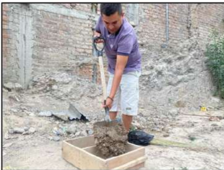
Fotografía 9: Llenado de la mezcla al molde del adobe
