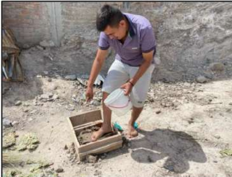
Fotografía 8: Mezclado de la tierra, fibra de penca, y paja
