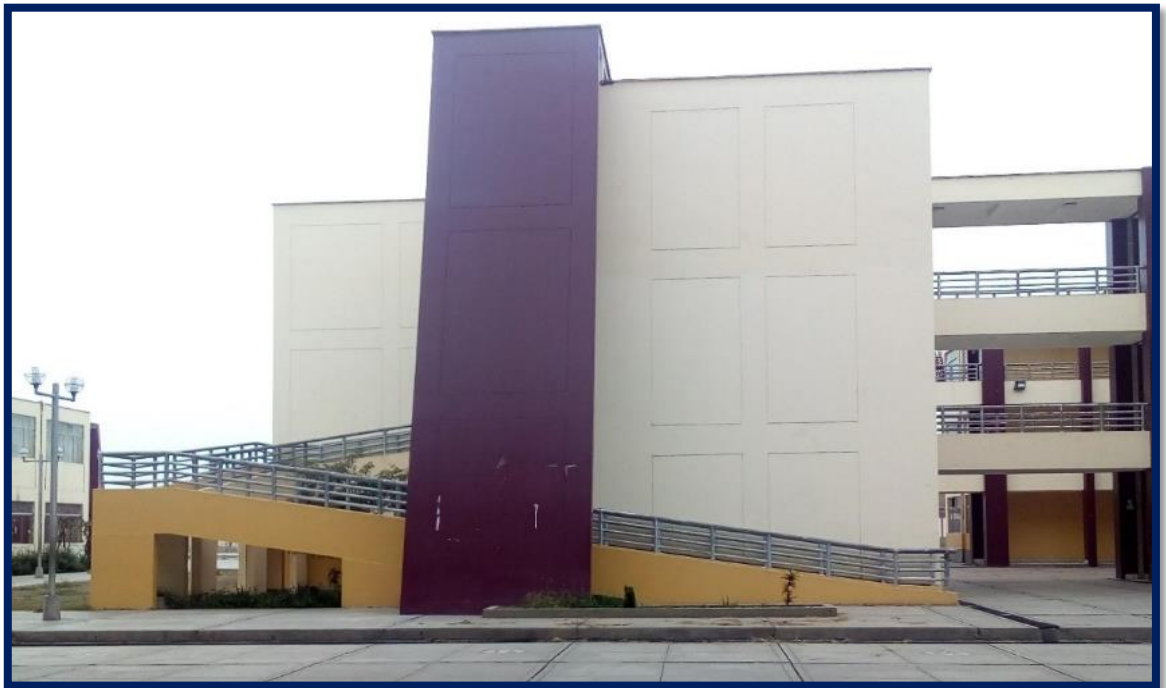
Rampas al segundo piso (un pabellon)
