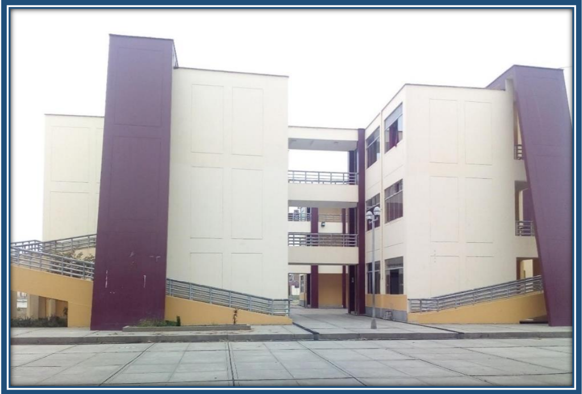
Rampas del primero al segundo piso (dos pabellones)
