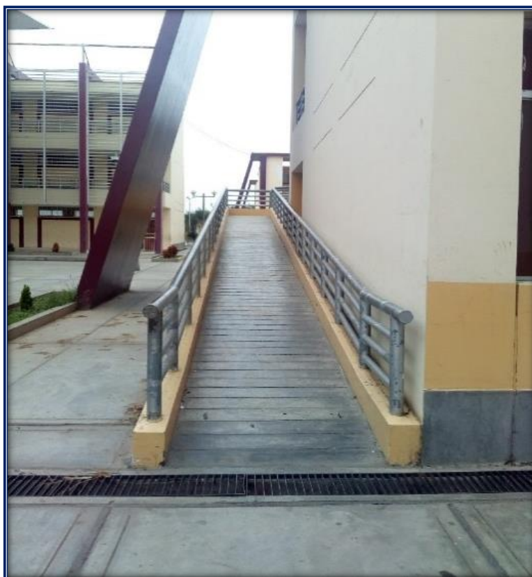
Vista frontal de Rampa al segundo piso (un pabellon)
