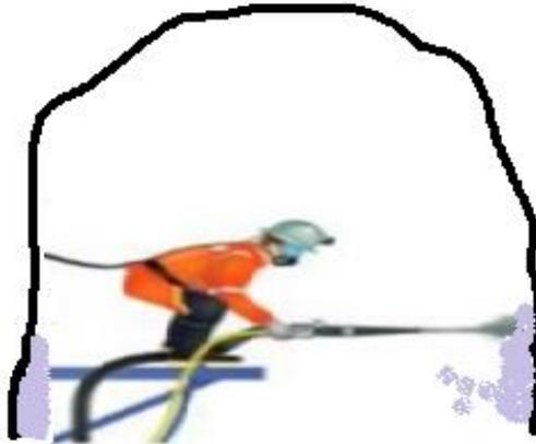
6. Una vez terminado de shotcretear la parte inferior de la labor se pasa a realizar el sostenimiento de manera perpendicular a la altura de la persona.
