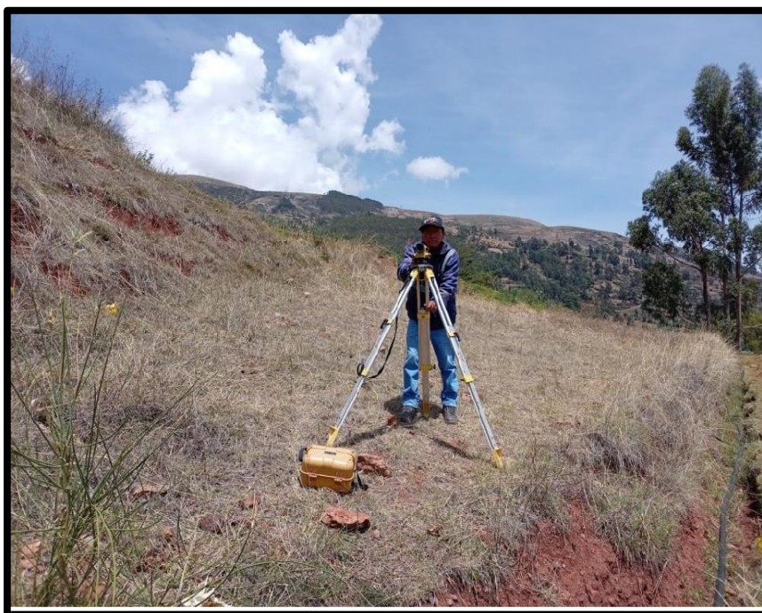
FOTO N° 10 NIVELACION DE LA LINEA DE CONDUCCION Y ADUCCION.
