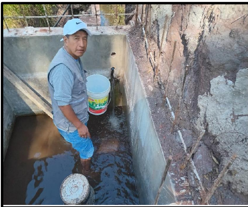
FOTO N° 02 AFORO EN CAPTACION (LADO IZQUIERDO)
